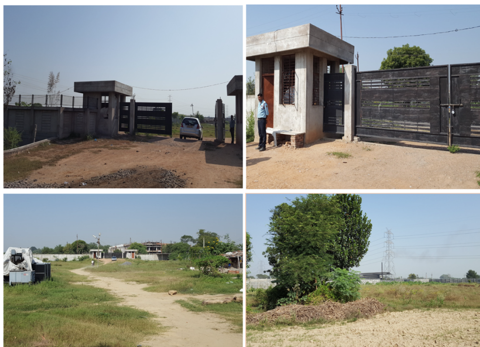
Figura 13- Instalação da planta nova
