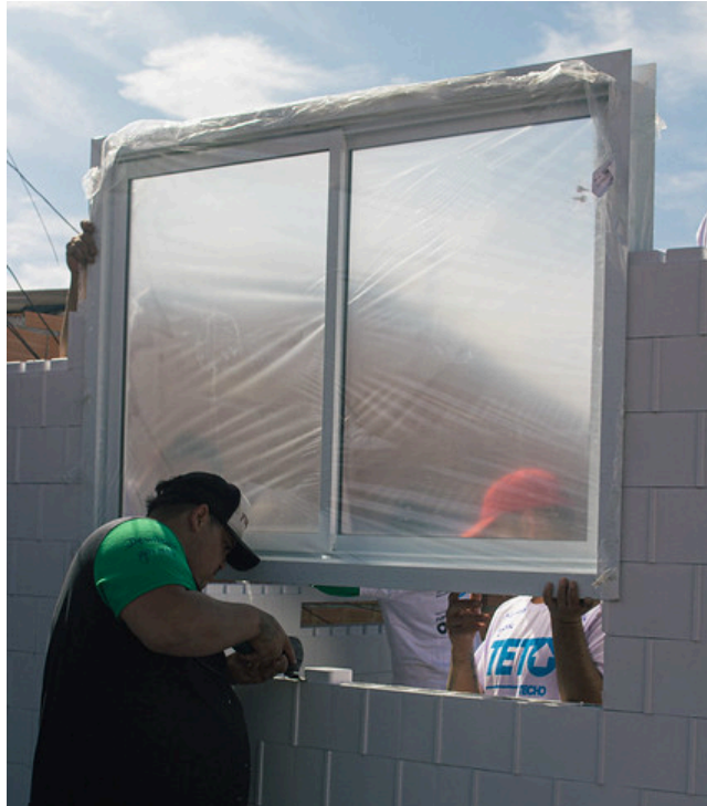
Figura 32: Instalação de janelas e corte na “cabeça” do bloco
