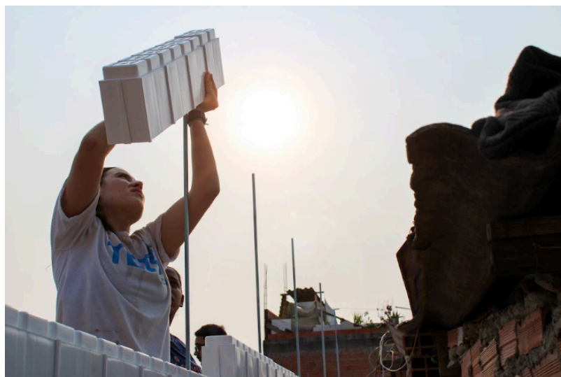
Figura 26: Processo de montagem dos blocos de polipropileno
