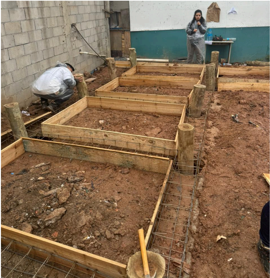
Figura 17: Caixas de contenção do concreto
