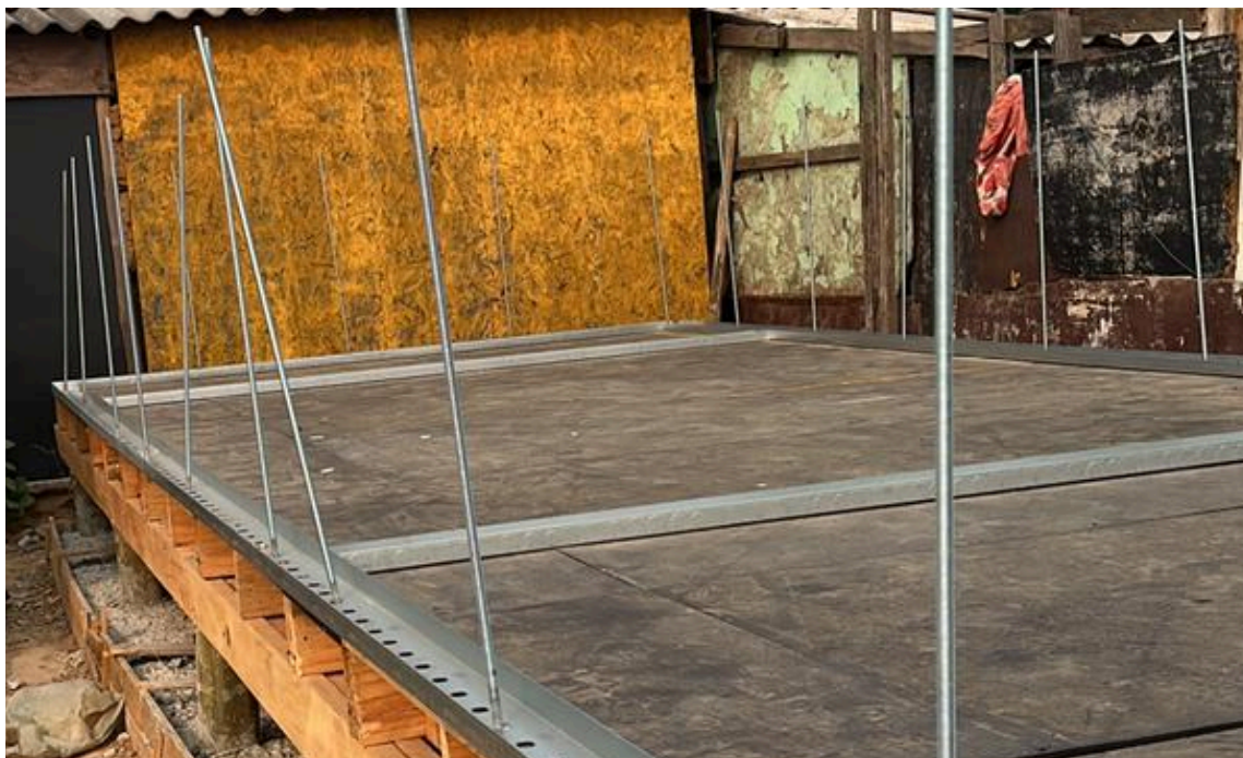
Figura 25: Posição dos vergalhões na estrutura de piso
