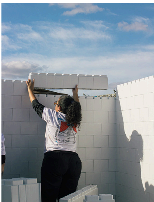
Figura 31: Montagem dos blocos de polipropileno por voluntários
