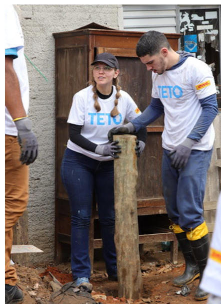
Figura 9: Posicionamento do piloti no solo
