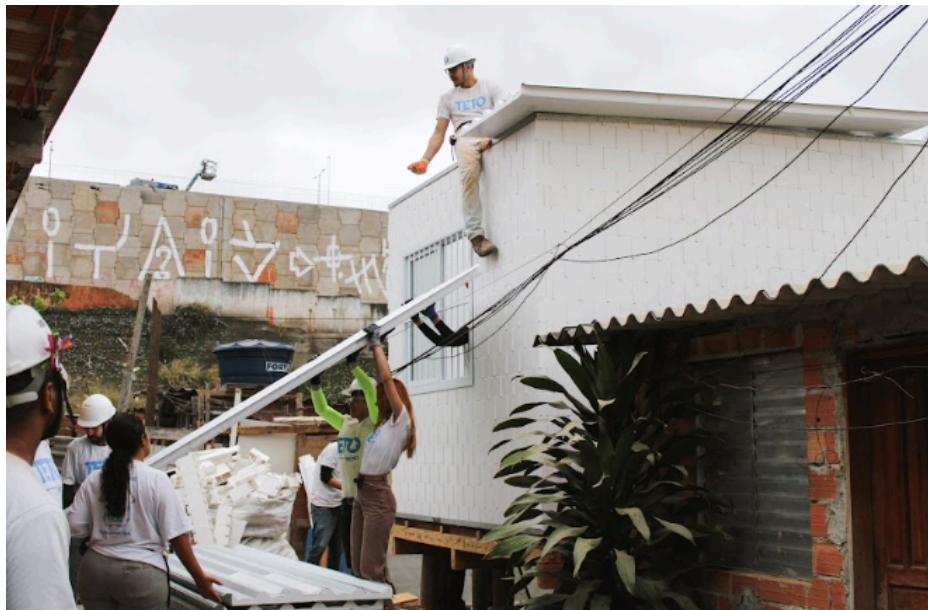
Figura 39: Processo de instalação das telhas
