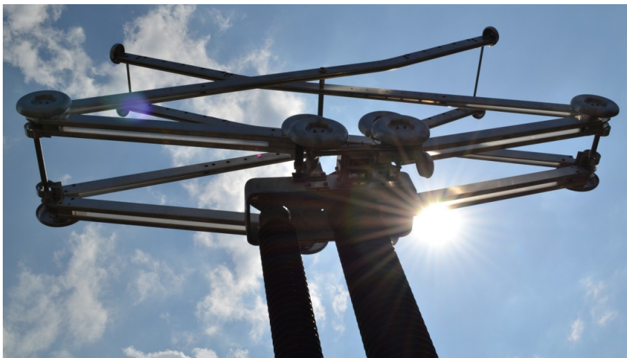
Figura 11: Chave seccionadora de abertura pantográfica da SIEMENS. Fonte: ( SIEMENS, 2020b ).
