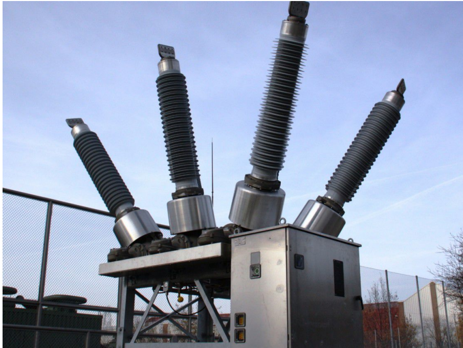
Figura 7: Imagem de um disjuntor com isolamento a SF 6 . Fonte: (SIEMENS, 2020a).
