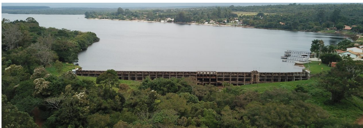
Figura 22: Vista aérea da barragem e reservatório da Usina Lobo Fonte: ( CHREA, 2020 )
