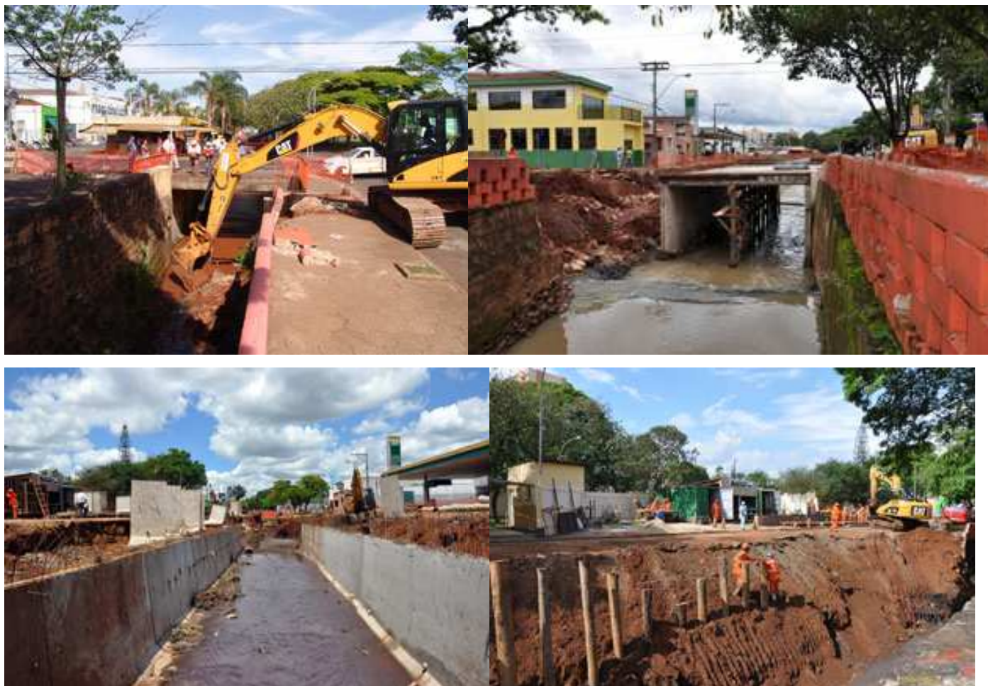
Foto 23: Obras de contenção às enchentes.
