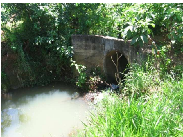
Foto 13: Fim do trecho canalizado do do Córrego do Sorregoti.
