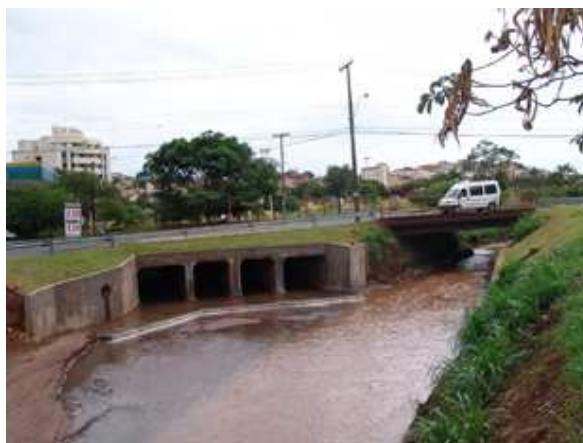
Foto 22: Recuperação de ponte.
