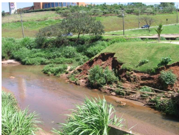
Foto 1: Erosão das margens na foz do Córrego Gregório, onde desemboca no Córrego Monjolinho.
