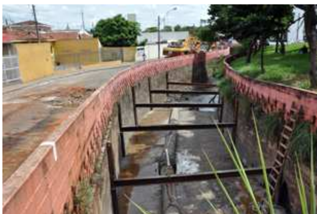
Foto 24: Recuperação de canalização.
