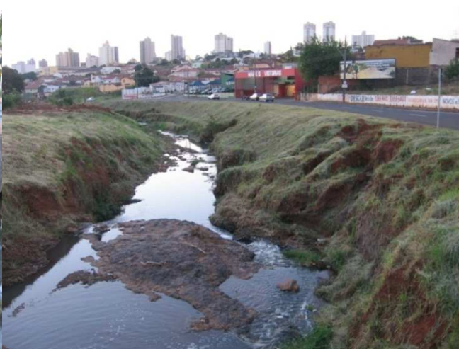
Foto 8: Córrego do Gregório, erosão nas margens.
