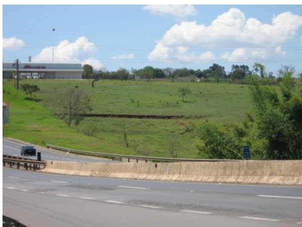
Foto 11: Rodovia Washington Luis, com detalhe para feição erosiva.
