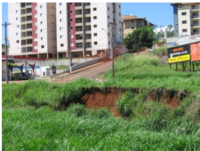
Foto 3: Erosão nas margens do Córrego Gregório.
