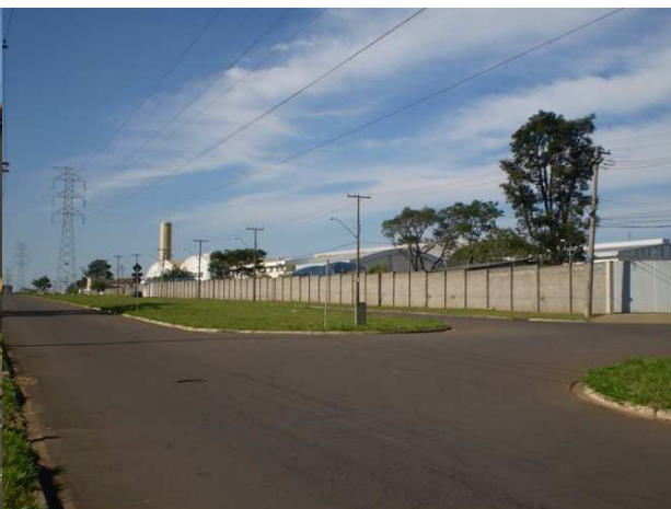
Foto 18: Muro do Distrito Industrial.
