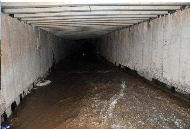
Foto 12: Trecho canalizado do Córrego Gregório, anterior ao ponto 6.
