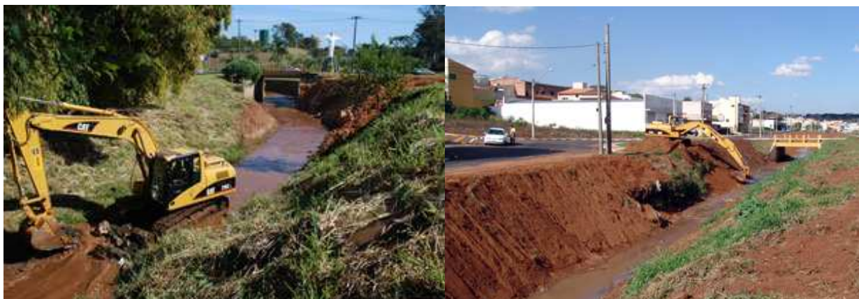
Foto 21: Obras de contenção de encostas.
