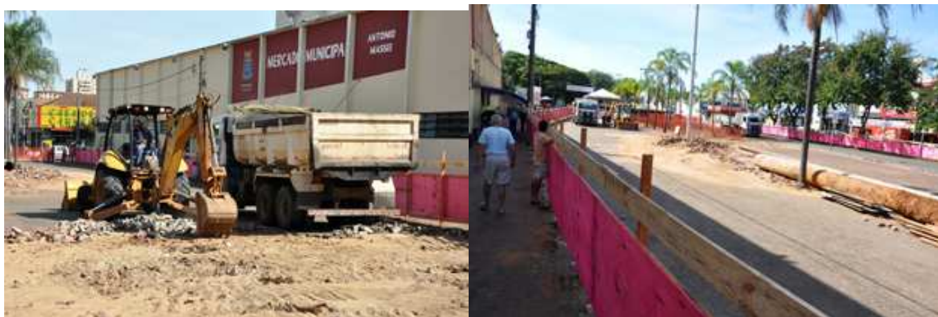
Foto 25: Obras de contenção às enchentes.
