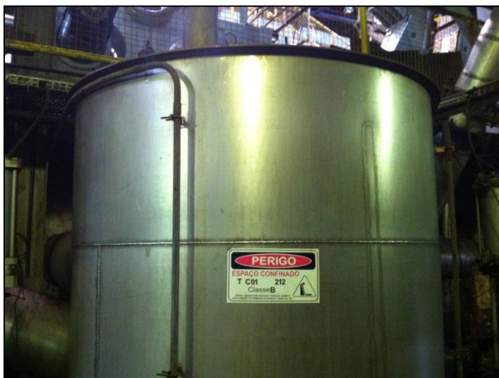
Figura 8 - Identificação de espaço confinado – NR 33 Fonte: Arquivo pessoal
