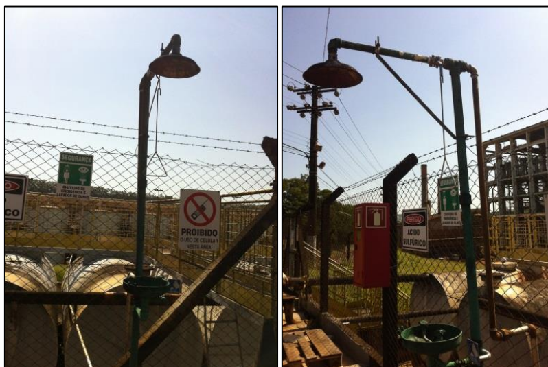
Figura 14 - Chuveiro de emergências Fonte: Arquivo pessoal
