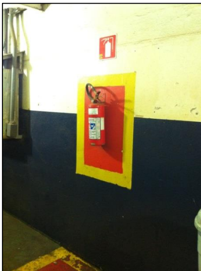
Figura 4 - Demarcação dos extintores de incêndio Fonte: Arquivo pessoal
