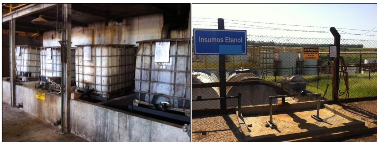
Figura 10 - Construção de bacias de contenção Fonte: Arquivo pessoal
