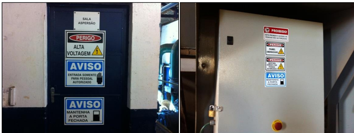
Figura 7 – Adequações aos painéis elétricos – NR10 Fonte: Arquivo pessoal
