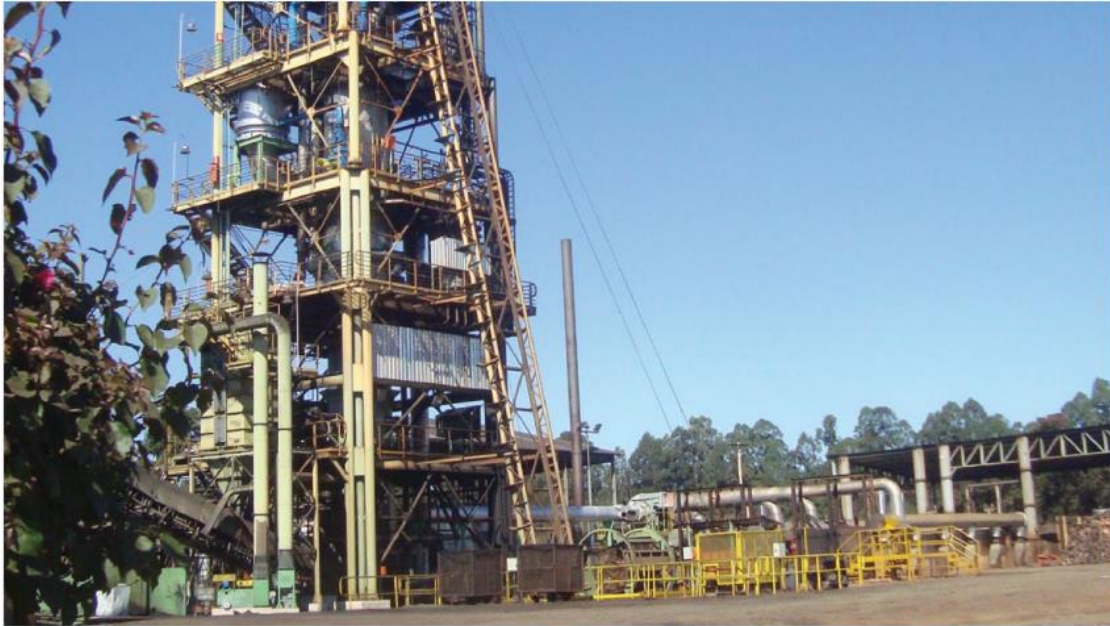
Figura 3 - Reator Carboval de produção de carvão vegetal da Vallourec [2]
