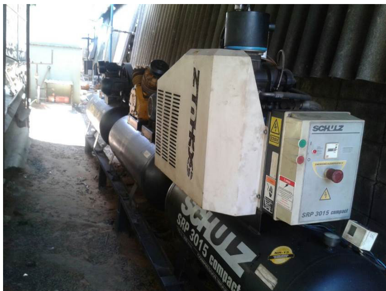
Foto 62 – Compressores de ar
