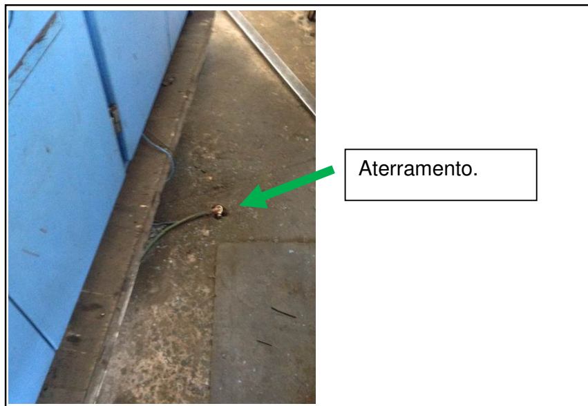
Foto 34- Detalhe aterramento
