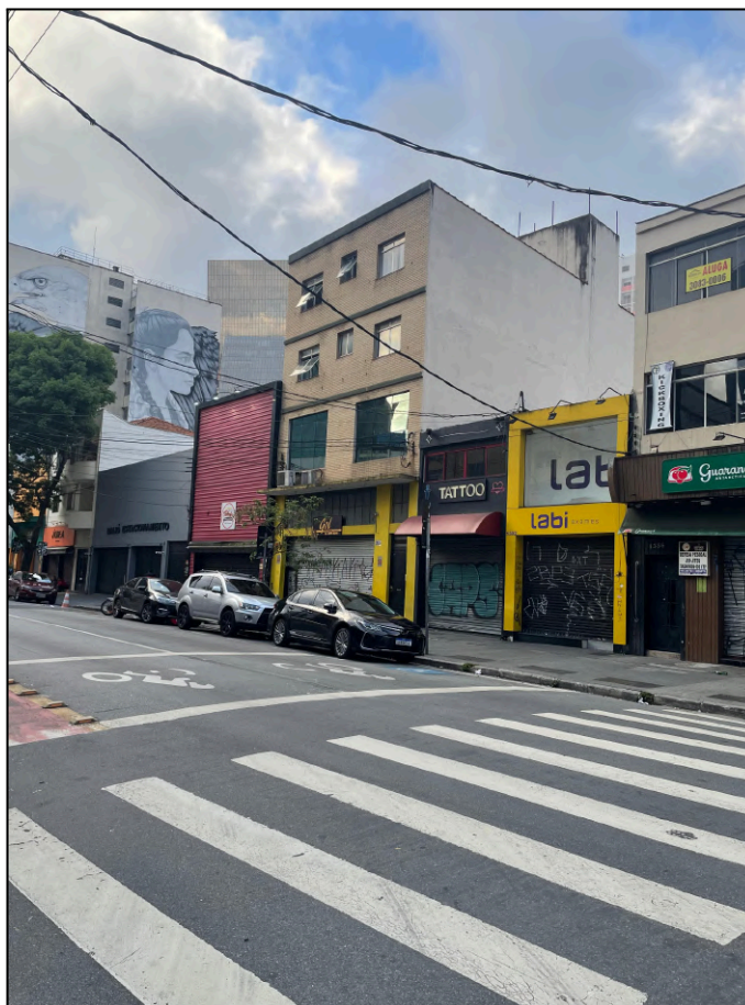
Figura 16 - Edificações horizontais remanescentes.
