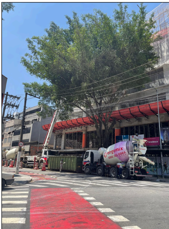
Figura 20 - Canteiro de obras.
