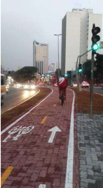
Figura 3 - Ciclovía bidirecional em canteiro central, Rua Vergueiro
