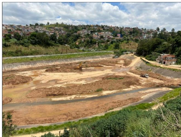
Figura 21. Obras de Desassoreamento do Reservatório de contenção
