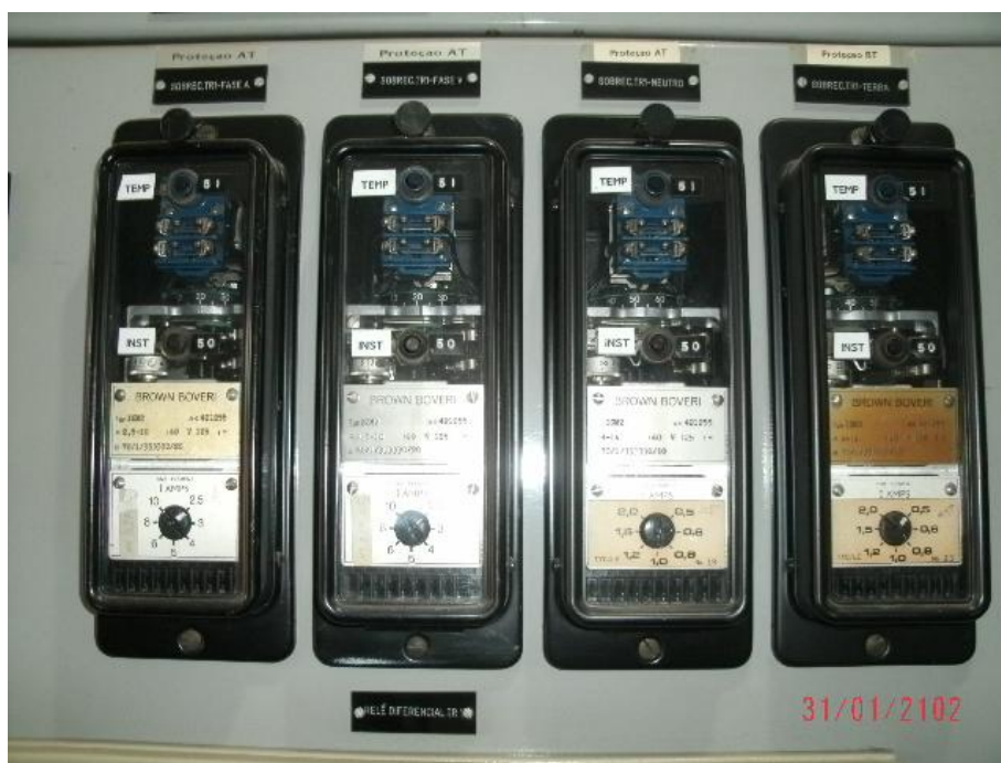
Figura 17: relés eletromecânicos instalados em um painel
