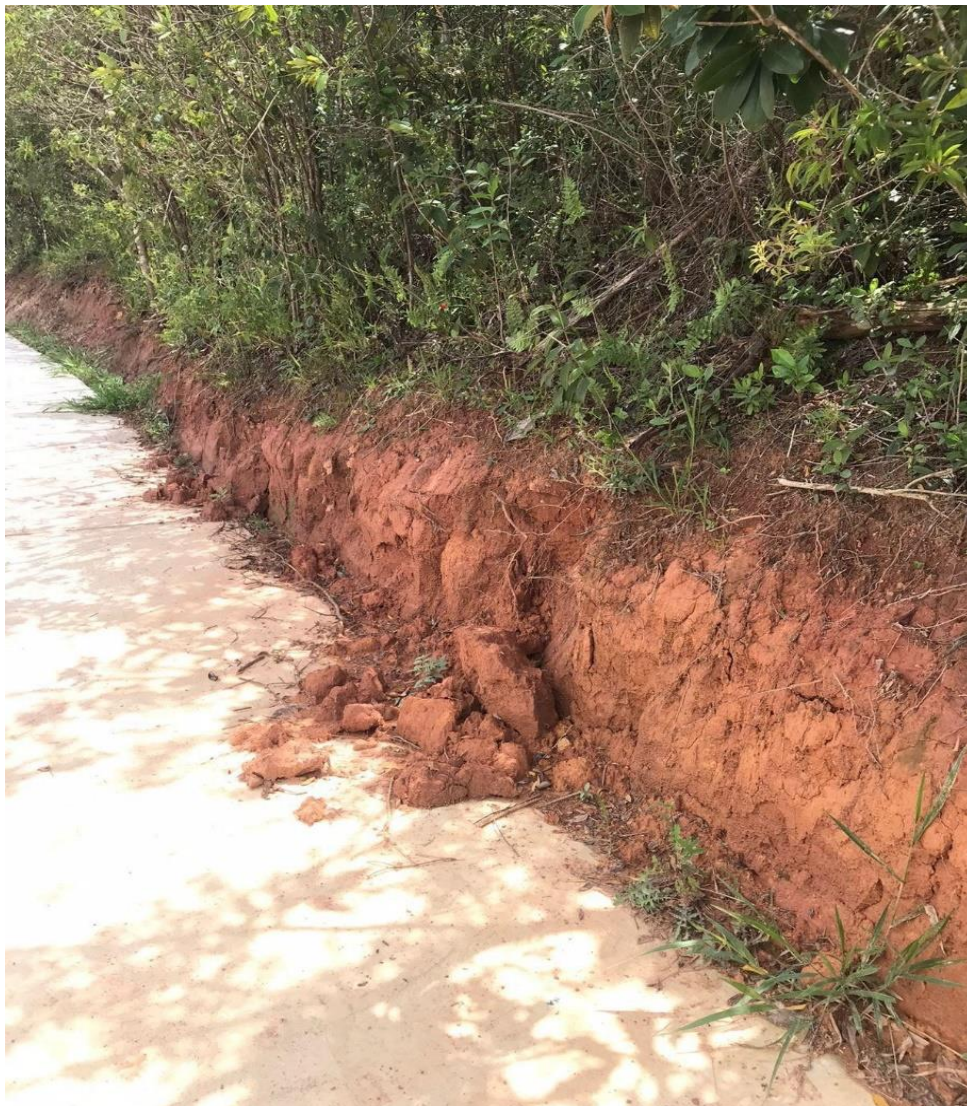
Figura 10: Deslizamento de terra no corte feito na vertente para construção de pista de caminhada de concreto. Fonte: fotografado por Fernando R. M, 2021.
