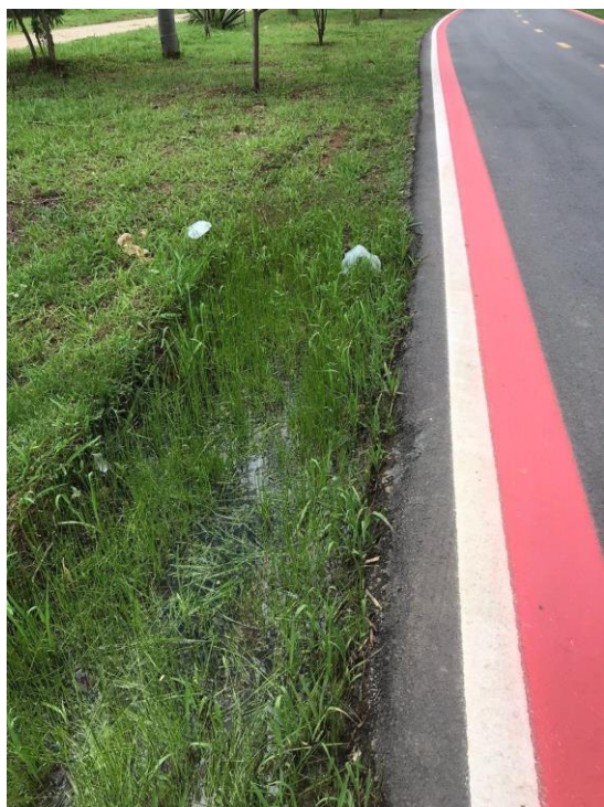
Figuras 11 e 12: Ponto de solo encharcado ainda sem infraestrutura de drenagem. Fonte: fotografado por Fernando R. M, 2021.
