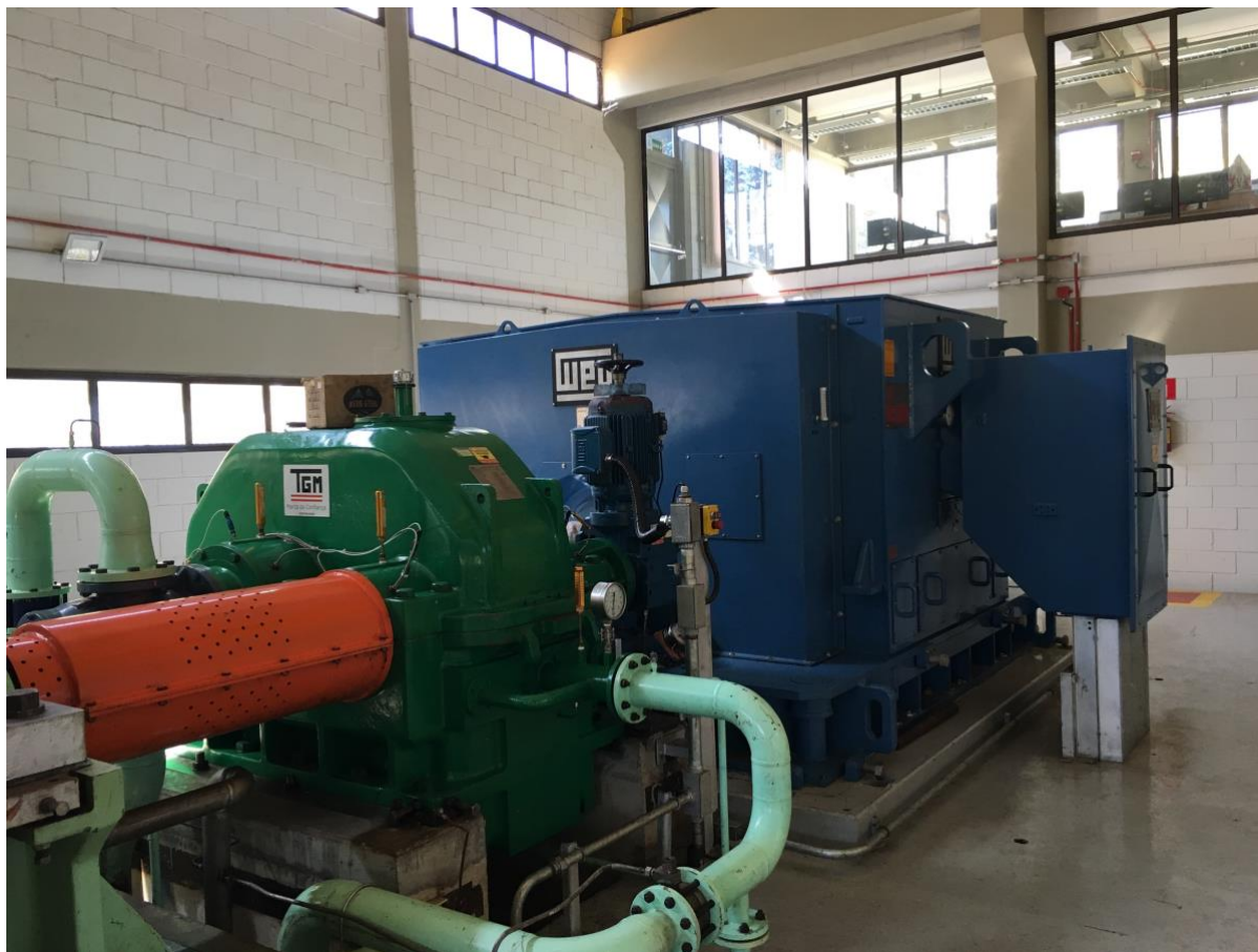
Figura 26 – Turbina TGM (Verde) e Gerador WEG (Azul) responsáveis pelo processo de cogeração.
