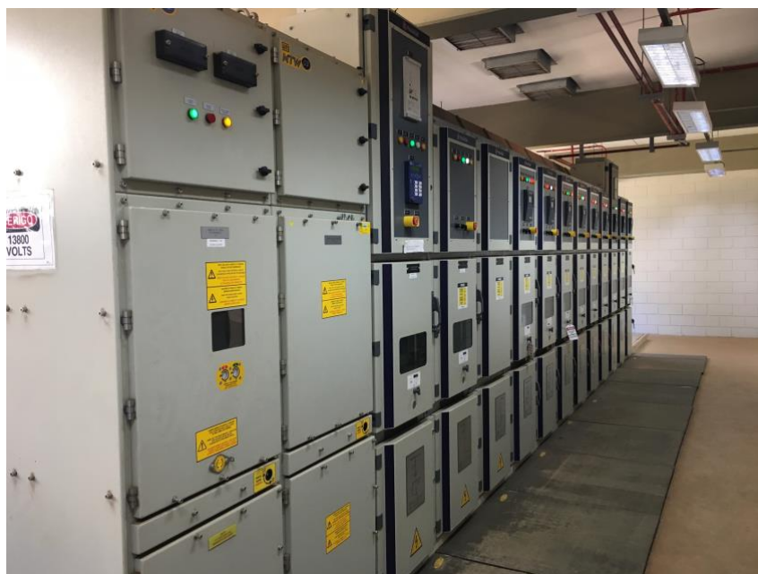
Figura 29 – Painéis elétricos para controle do sistema de geração da usina.
