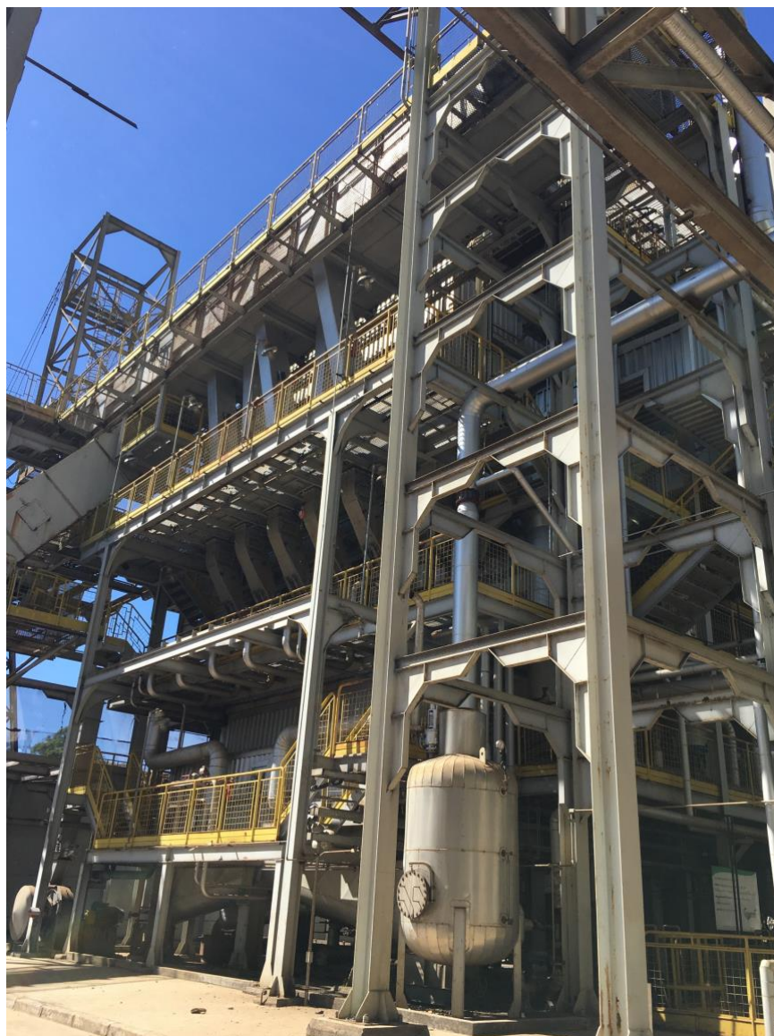
Figura 25 – Caldeira de 42 bar de pressão e 450 °C.
