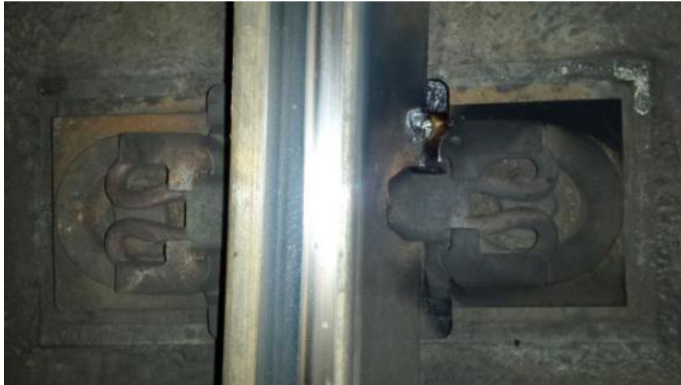
Figura 7 – Caso 2: Perda de material e Fusão do Patim. Fonte: O próprio autor, 2016.
