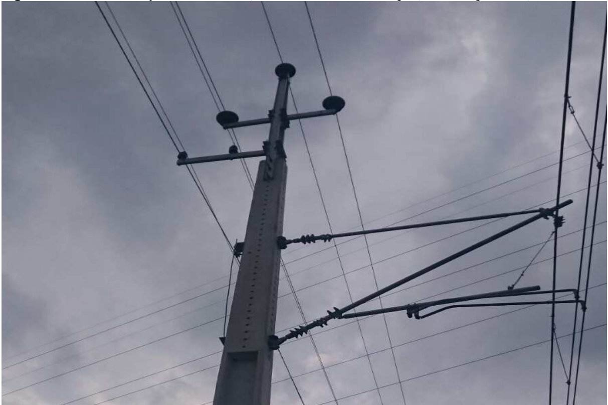
Figura 2.2 - Detalhe do poste da linha 7, com rede aérea de tração, sinalização e 34,5 kV
