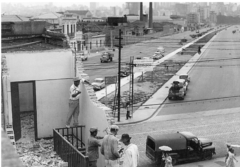
Demolição de construções para implantação da Avenida Radial Leste, no Brás.
