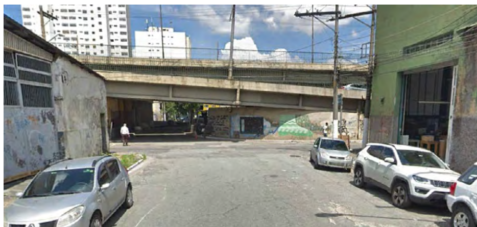
Rua André de Leão, passagem sob viaduto.
