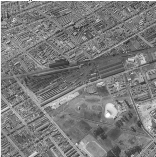
Pátio Engenheiro São Paulo
