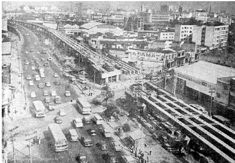
Construção do viaduto para transpor a Estrada de Ferro Santos-Jundiaí, trecho sobre a rua Piratininga.
