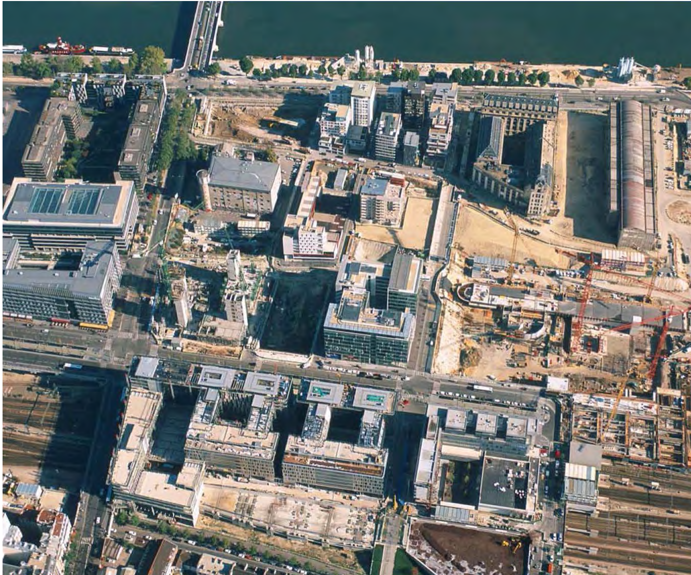
Foto da construção do setor Mássena, em 2003. A direita, posicionamento das vigas na construção da Avenue de France pela SEMAPA. Na parte inferior, o desenvolvimento privado sobre os trilhos, em lotes de aproximadamente 60x60 m.
