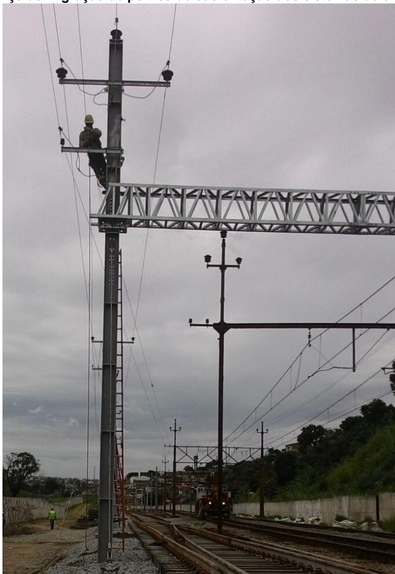
Figura 2.1 - Serviço de migração de pórtico de sustentação dos sistemas de energia da CPTM
