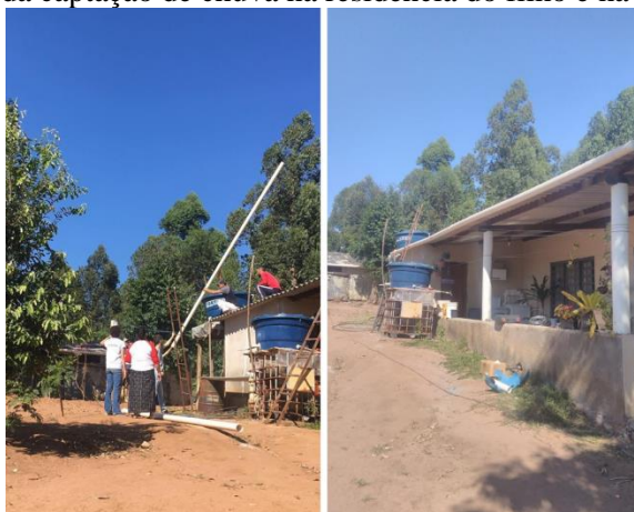
Figura 23: Construção da captação de chuva na residência do filho e na casa de costura.
