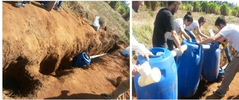
Figura 9: Construção da fossa por bombonas.
