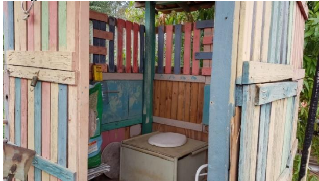
Figura 5: Área interna do banheiro seco.
