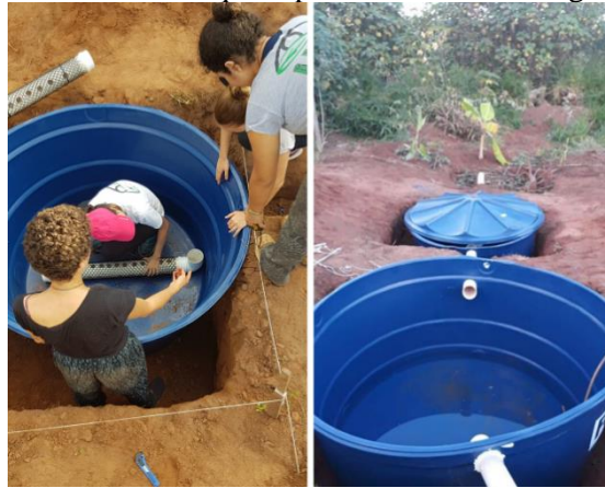
Figura 19: Sistema de tanque séptico com filtro biológico.
