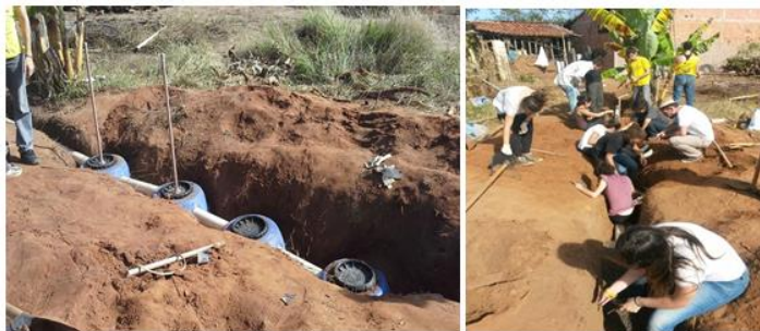
Figura 10: Construção da fossa biodigestora.
