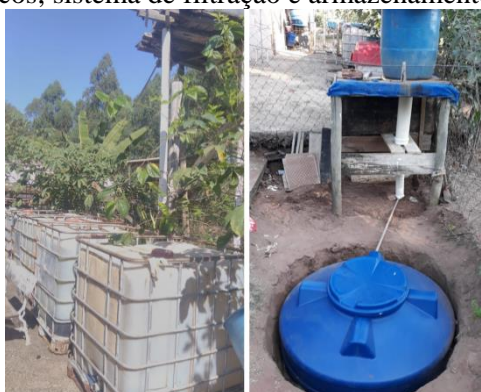
Figura 22: Tanques brancos; sistema de filtração e armazenamento da água filtrada.
