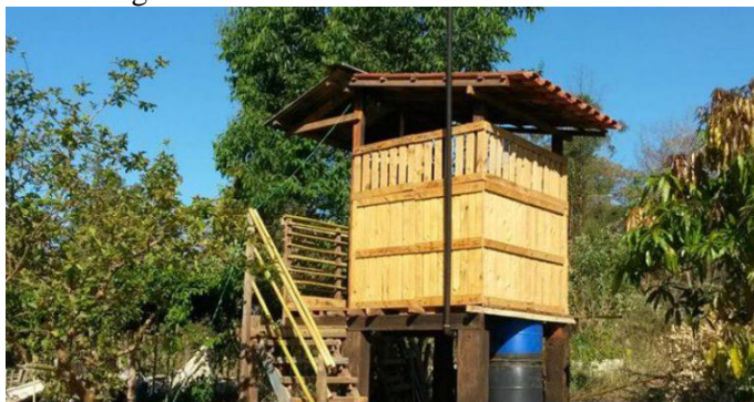
Figura 4: Banheiro seco finalizado.
