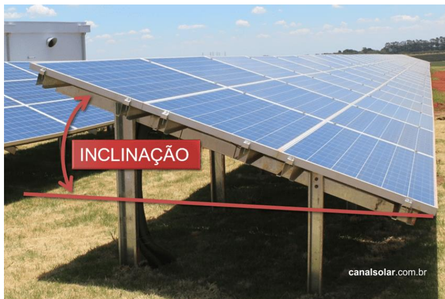
Figura 2.5 - Posicionamento de módulos em centrais fotovoltaicas
