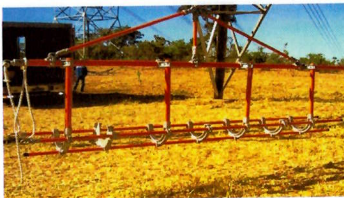
Figura 30 – Subida do berço de ancoragem
