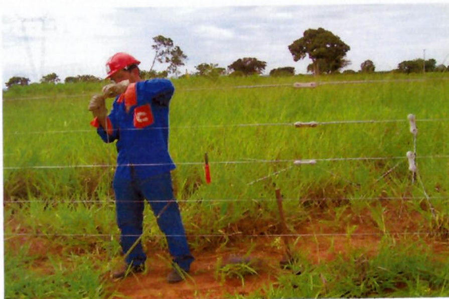
Figura 10 – Etapa 1 da aplicação do seccionador pré-formado
