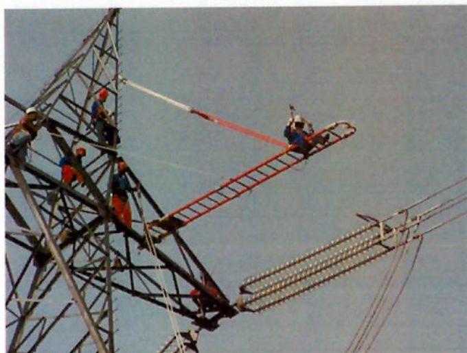
Figura 31 – Deslocamento eletricista ao potencial através da escada auxiliar
