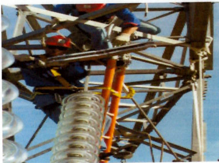
Figura 22 – Instalação jugo lado morto
