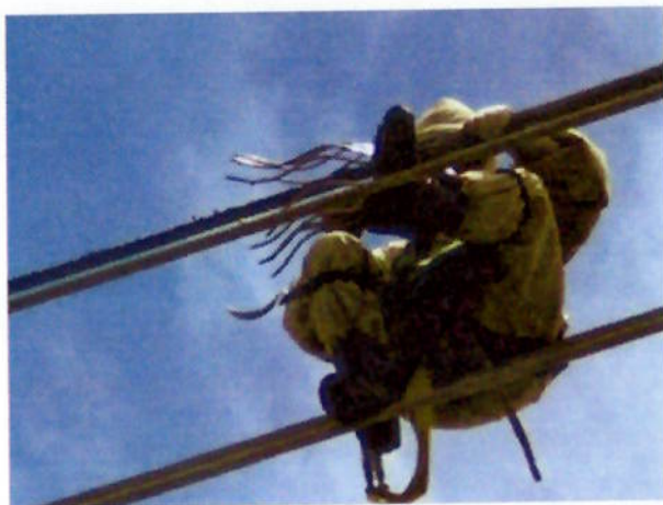
Figura 37 – Reparo em cabo Condutor
