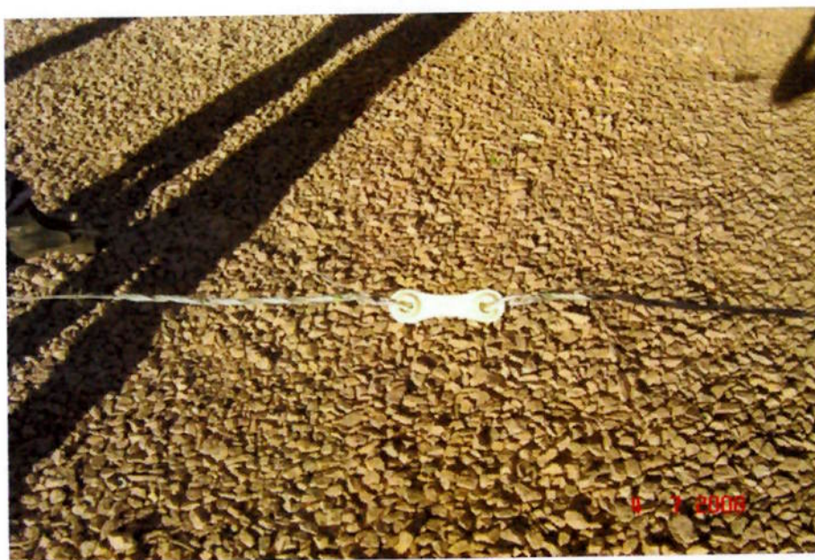
Figura 13 – Etapa 4 da aplicação do seccionador pré-formado
