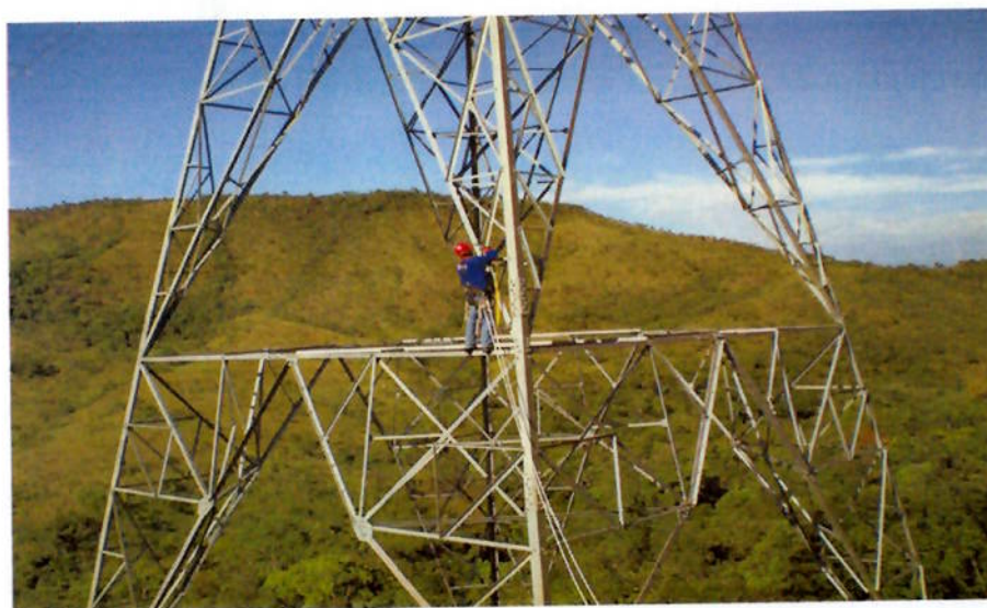
Figura 15 – Subida na Torre utilizando “talabarte em Y”
