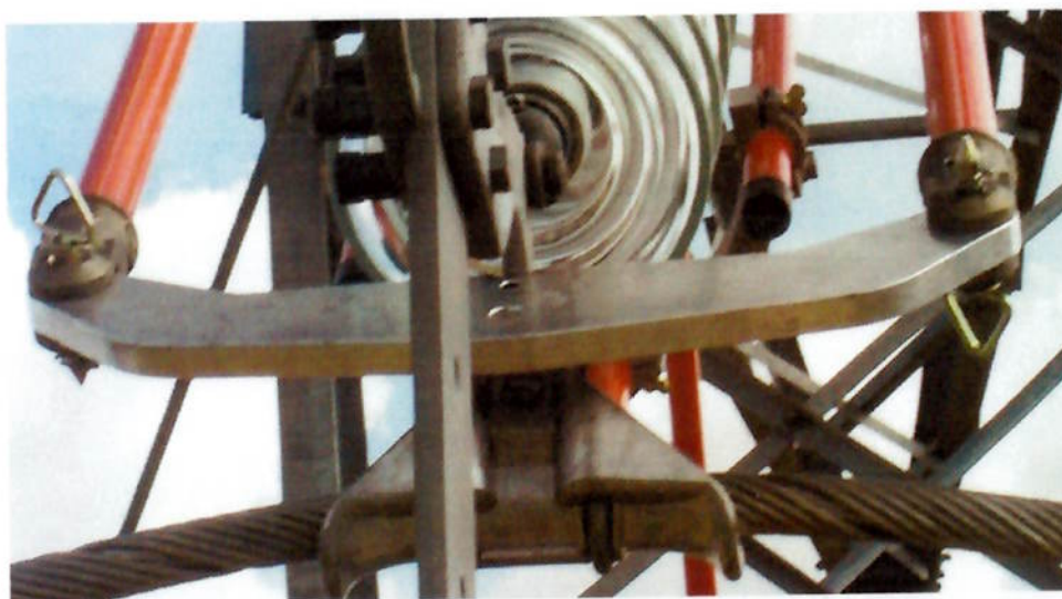
Figura 23 – Instalação jugo lado vivo
