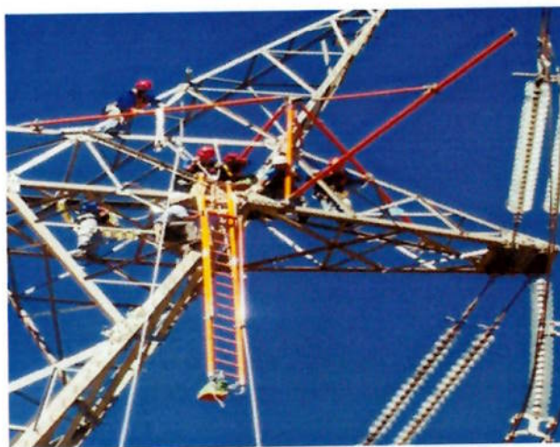
Figura 29 – Instalação de escada auxiliar
