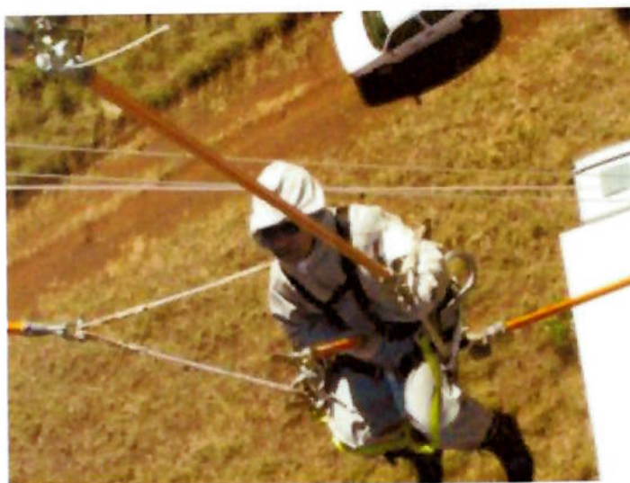
Figura 20 – Subida do eletricista ao potencial pela cadeira
