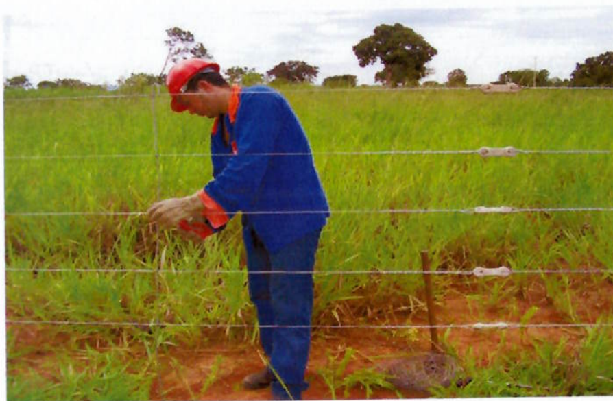
Figura 9 – Seccionador pré-formado
