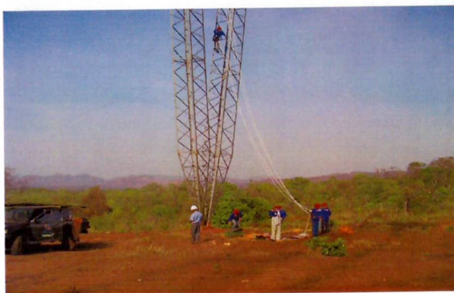
Figura 16 – Escalada dos eletricitas com as cordas
