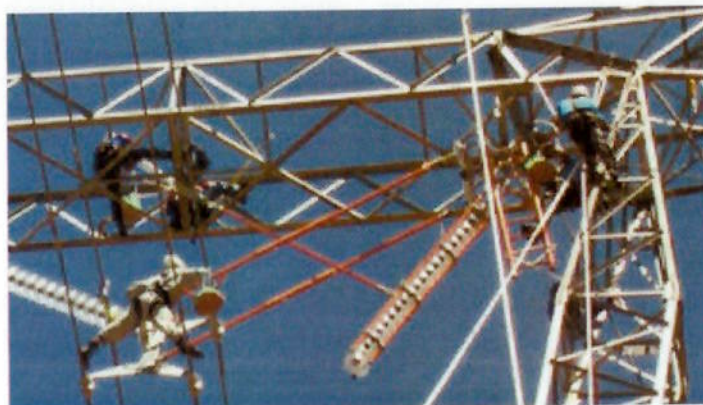
Figura 28 – Descida de cadeia de isoladores para vertical
