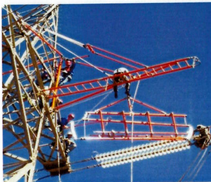
Figura 34 - Instalação berço de ancoragem na cadeia de isoladores
