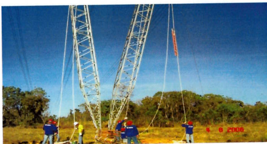
Figura 17 – Içamento da escada para torre
