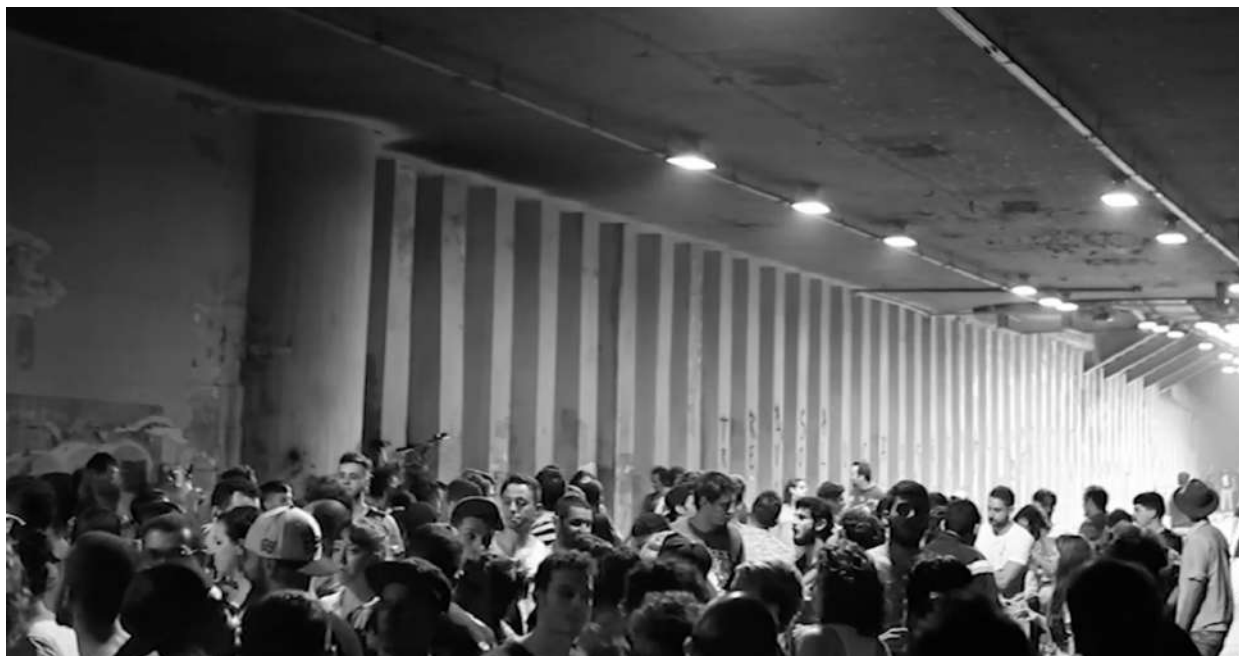
FIGURA 19 - BURACO DA MINHOC A EM SÃO PAULO
