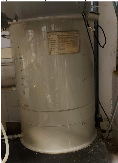
Figura 6: Tanque de Base para Bomba
