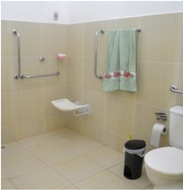
Sanitário das unidades habitacionais. Foto: Krystine Carneiro/G1.
