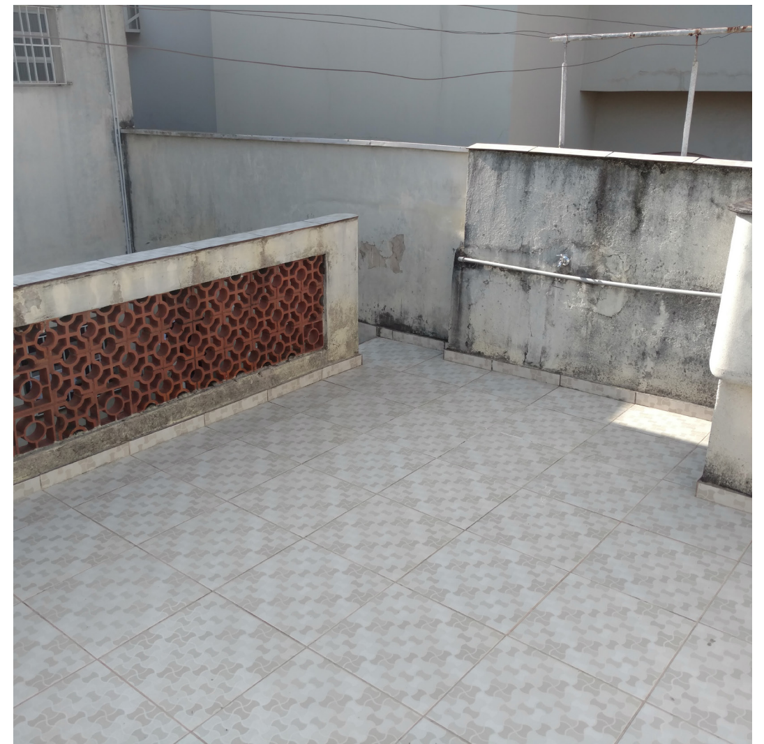
Sanitário, escada externa e terraço. Fonte: acervo da autora.
