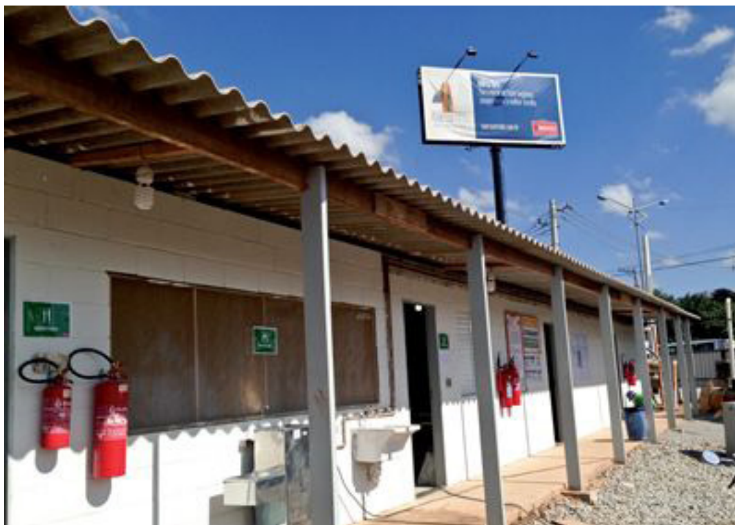
Figura 7: Construções temporárias em alvenaria - Revista Técnica
