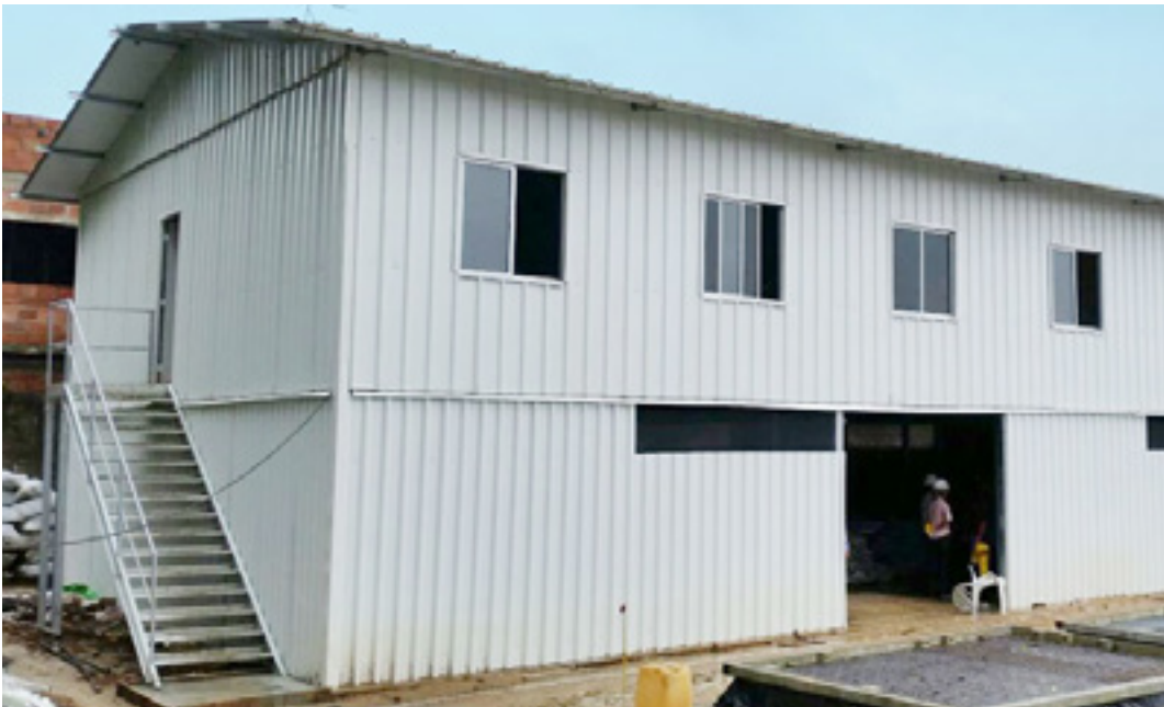
Figura 6: Construção temporária em estruturas metálicas – inova canteiro de obras
