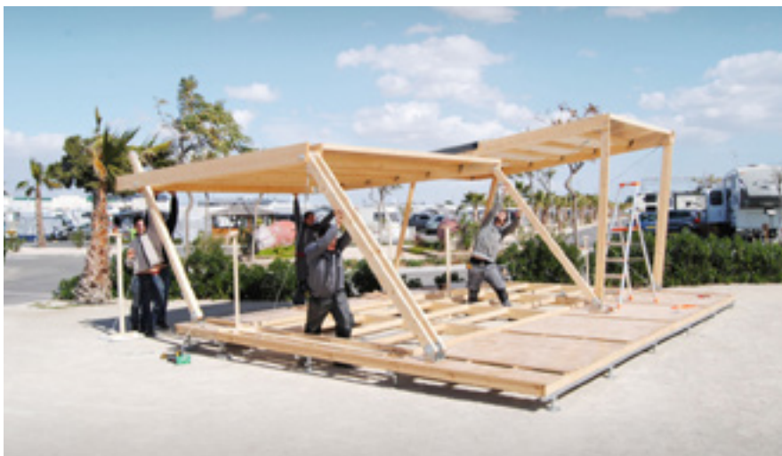
Figura 20: Detalhe da estrutura flexível e dos encaixes metálicos-archdaily
