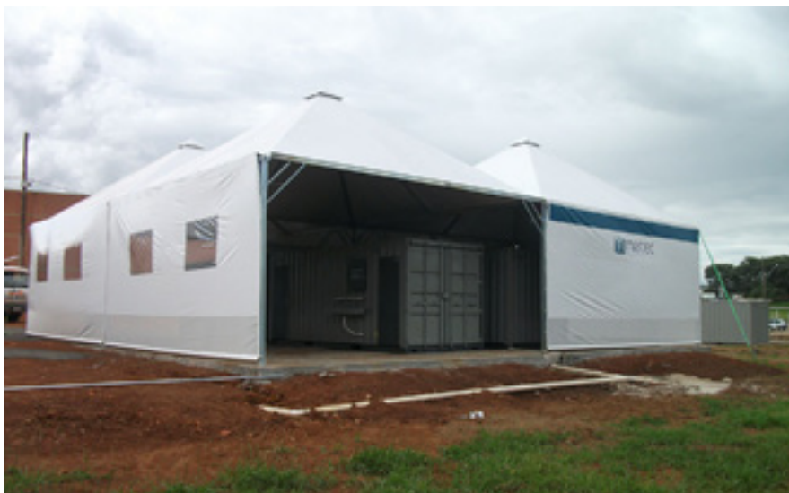
Figura 8: Utilização de tenda para cobertura de instalações provisórias em containers
