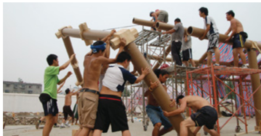
Figura 11: Voluntários executando a estrutura (detalhe do nó) - archnet
