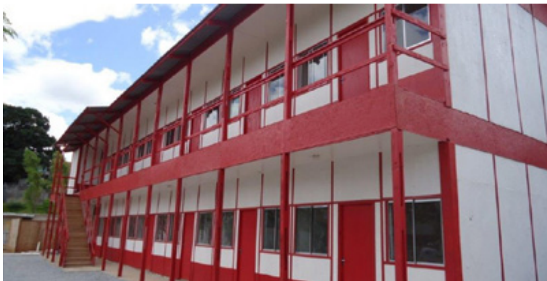
Figura 4: sistema de pré-fabricado de madeira - BAMA Engenharia
