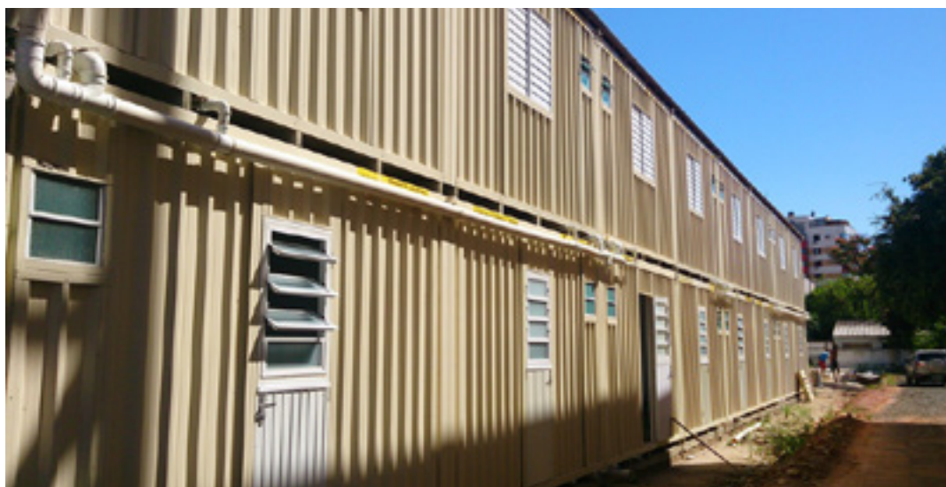
Figura 5: Instalações provisórias em containers - Grupo Colmeia
