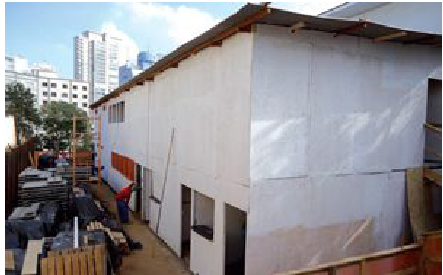
Figura 3: Construção temporária em compensado de madeira - Revista Técnica
