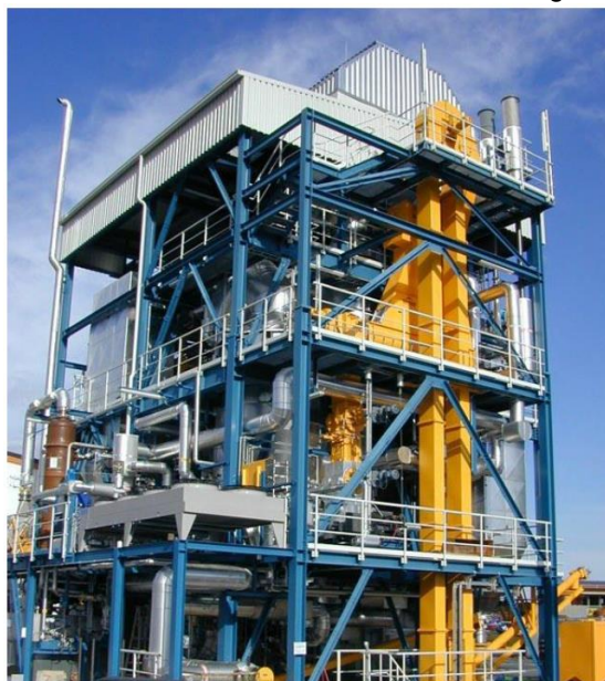
Figura 6.7 - Gaseificador FICFB em Guessing - Áustria
