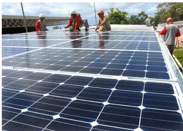
Figura 2 - Conjunto de módulos fotovoltaicos
