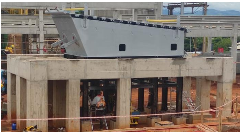
Figura 8 – Grelha vibratória caldeira MD-FV-50 (DANPOWER, 2021).
