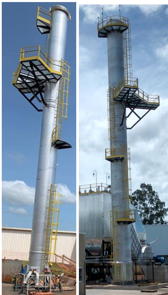
Figura 14 – Chaminé de uma caldeira MD-FV-50 (DANPOWER, 2021)
