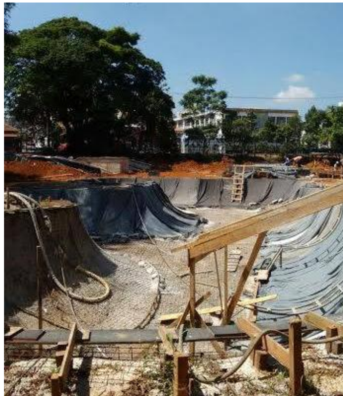
Figura 24: Construção da Pista de Skate.
