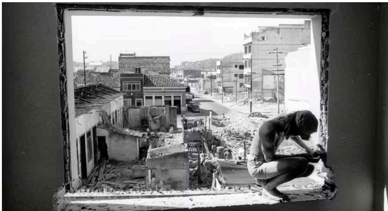
Figura 12: Demolições de casas no Catumbi para construção do Viaduto 31 de Março.
