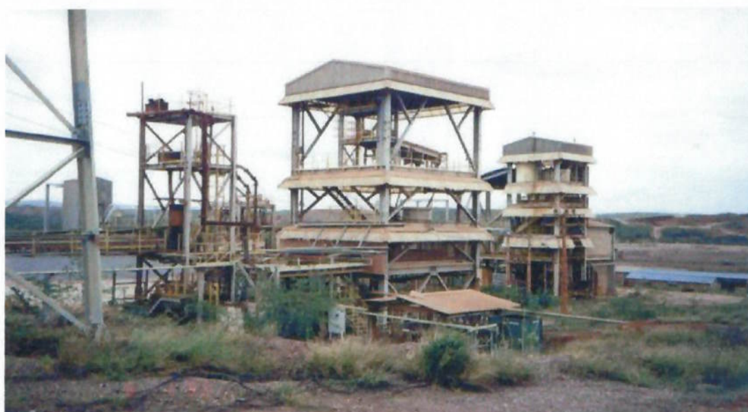
Foto 4 Vista geral das instalações de britagem
