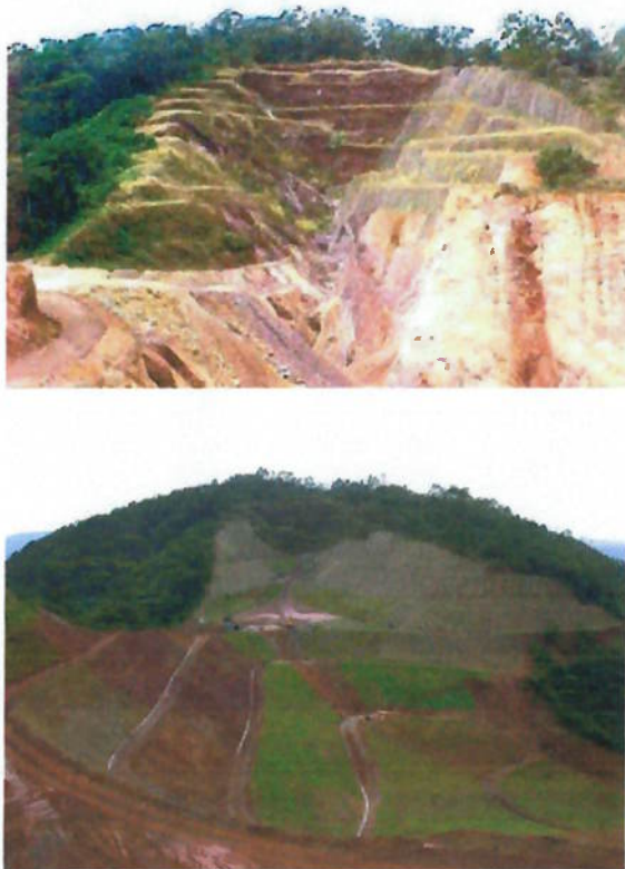
Foto 6 Imagens "antes (2001) e depois (2003)" da reabilitação ambiental em taludes na mina de Caeté
