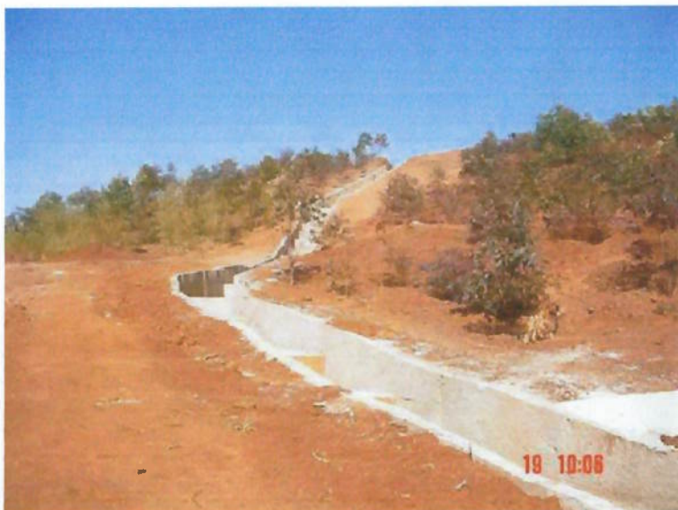
Foto 10 Escada de drenagem construída na Mina de Manganês do Fundão – SMM – Nazareno/MG durante processo de recuperação ambiental.
