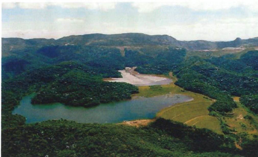
Foto 13 Vista geral da barragem de rejeitos da Mina de Águas Claras (MBR – Belo Horizonte/MG)
