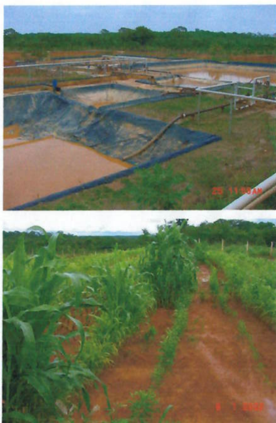
Foto 8 Imagens ANTES: (2001) Tanques de lixiviação, com a Planta em fase final de operação e DEPOIS: (2002) Área toda coberta com material das pilhas lixiviadas e com uma camada de 50 cm de solo para viabilizar a vegetação.
