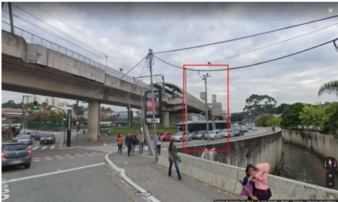
Figura 31 - Estação Campo Limpo/CGE, Avenidas Carlos Caldeira Filho x Rua Túlio Mugnaini, - 23.65818 -46.76749. Fonte: Google Maps Imagery, Google Maps Street View, jun. 2019.
