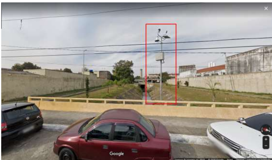
Figura 44 - Estação Penha/CGE, Rua Atuaí, 1009 x Praça Walter de Azevedo - Vila Esperança (Atrás da Estação Vila Matilde do Metrô), -23.530763 -46.528744. Fonte: Google Maps Imagery, Google Maps Street View, jul. 2018.
