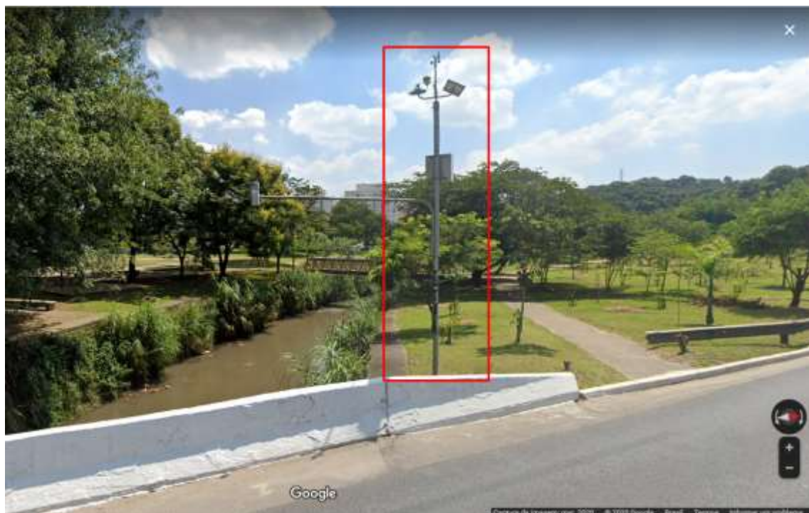
Figura 49 - Estação São Mateus/CGE, Av. Aricanduva, 12550 (próximo a Av. Ragueb Choffi) - Jardim Cinco de Julho, -23.594199 -46.465567. Fonte: Google Maps Imagery, Google Maps Street View, mar. 2020.
