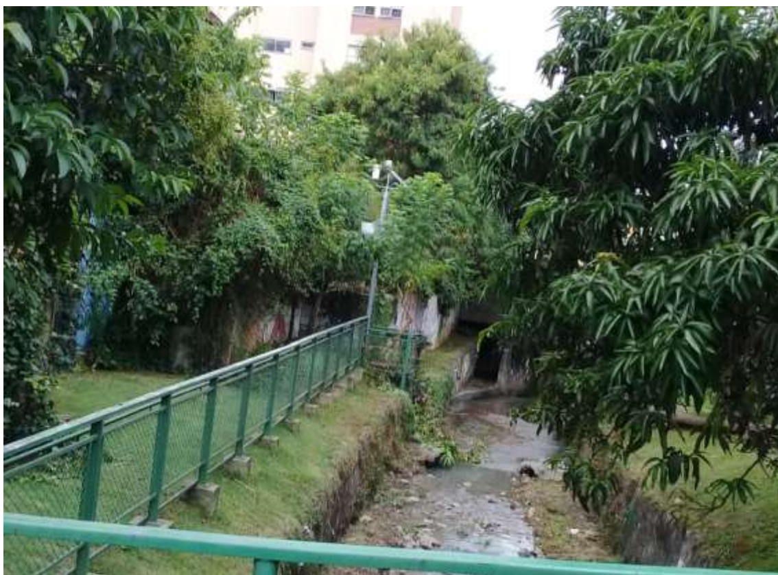
Figura 46 – Estação Pinheiros/CGE, Parque Linear das Corujas - Vila Madalena, -23.551871 -46.695939. Foto por: Rodolfo Alves, 2017.
