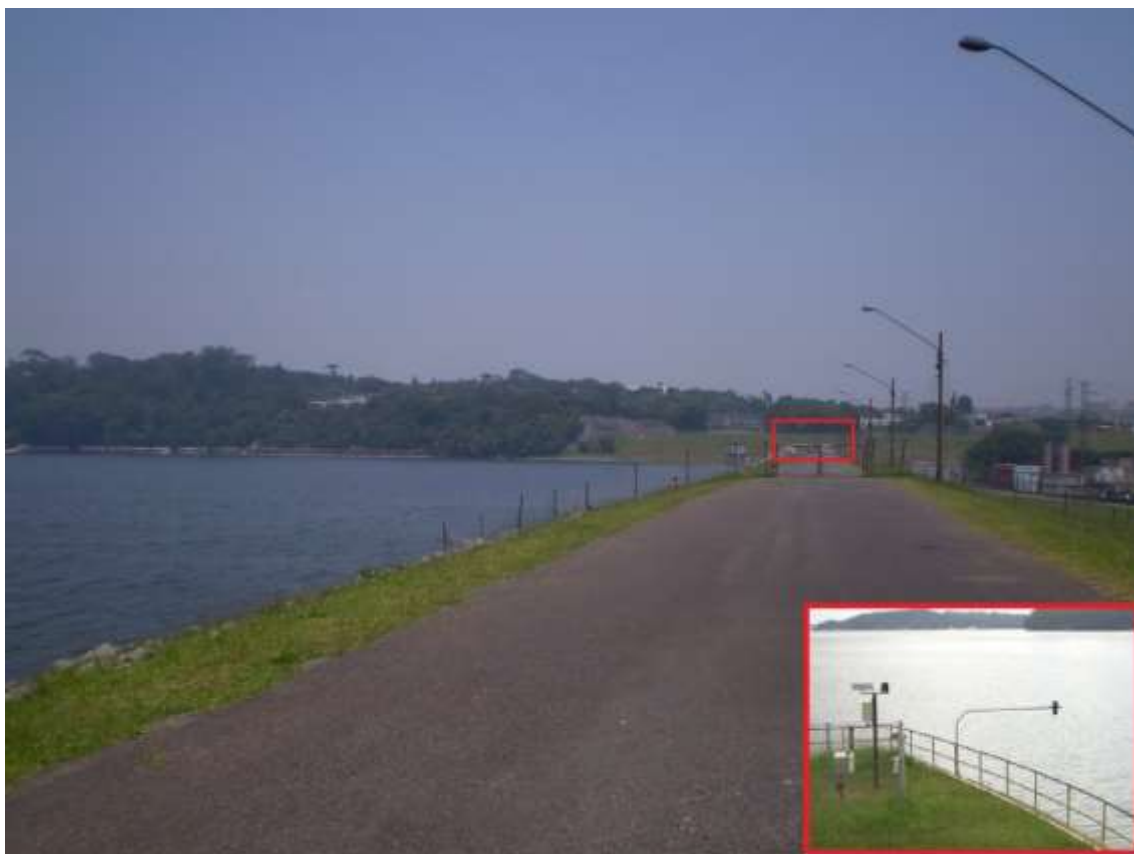
Figura 41 - Estação M'Boi Mirim/CGE, ao lado da barragem Represa de Guarapiranga, - 23.6714856871 -46.7273046498. Foto tirada por: Rodolfo Alves, 2017.
