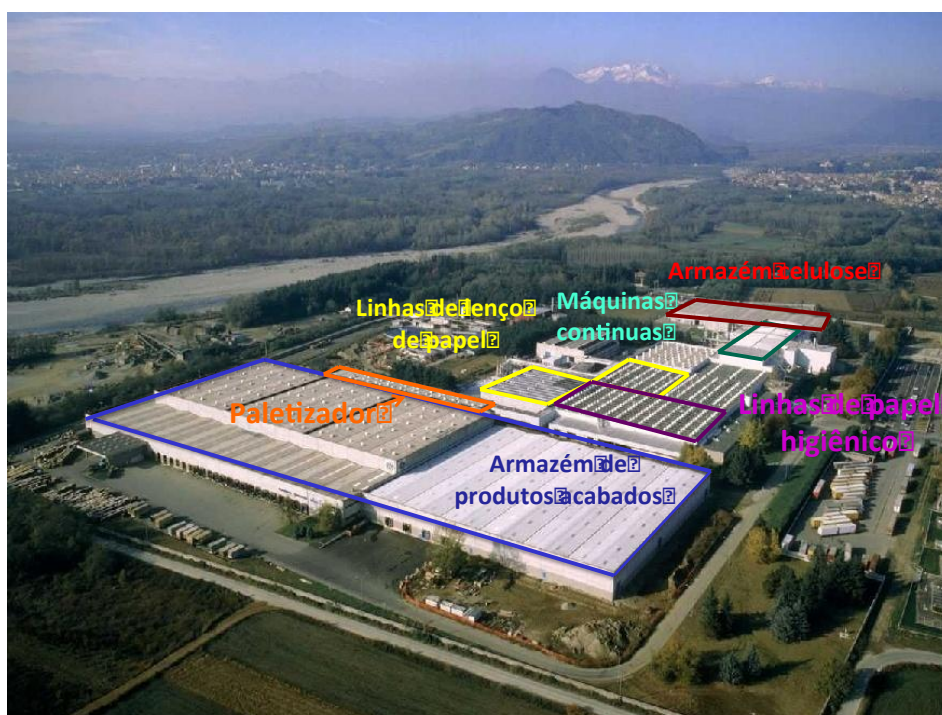
Figura 1.2 - Vista do alto dos departamentos da fábrica de Romagnano Elaborado pela autora
