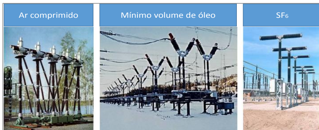
Figura 2 - Evolução das tecnologias: ar comprimido, mínimo volume de óleo e gás SF 6 .
