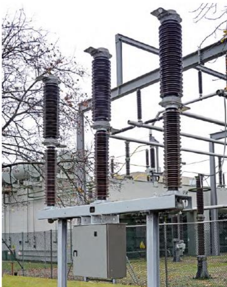
Figura 4: Exemplo de disjuntor de alta tensão para 145 kV [6].
