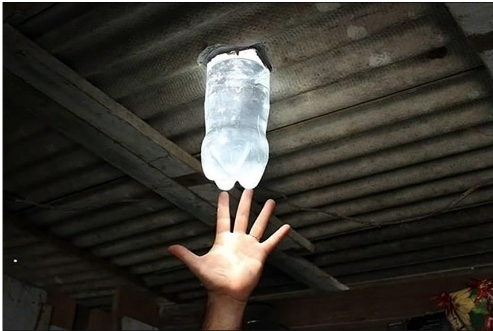
Figura 6 - Iluminação com Garrafa Pet
