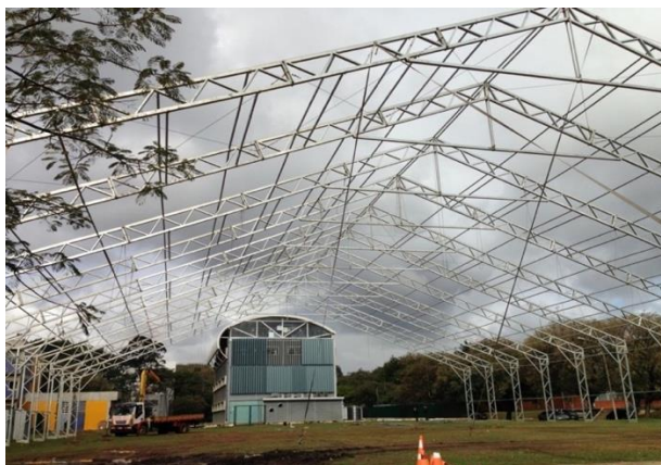
Figura 8 - Etapa de montagem da tenda provisória para o Workshop Integrativo
