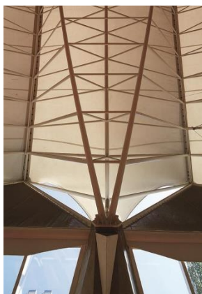
Figura 19 - Detalhe do encontro dos tubos de aço
