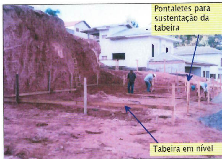
Figura 0.2 – Execução do gabarito da obra
