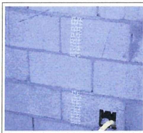
Figura 0.5 – Colocação de tela eletrosoldada para amarração de paredes
