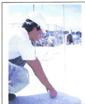
Figura 0.3 – Conferência do eixo de referência e marcação da alvenaria
