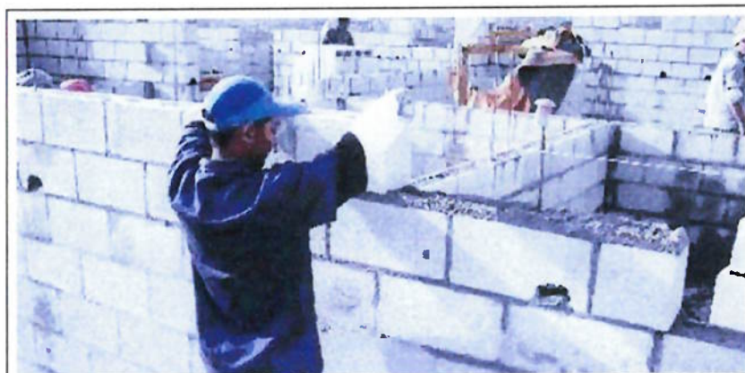
Figura 0.6 – Detalhe da utilização de nylon para garantir o nivelamento entre as fiadas
