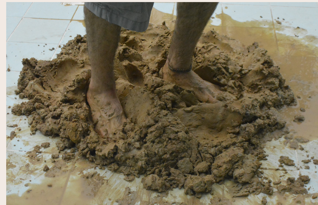
Figura 39. Processo de mistura da massa de adobe, por “pisagem”. Autoria própria, 2021.
