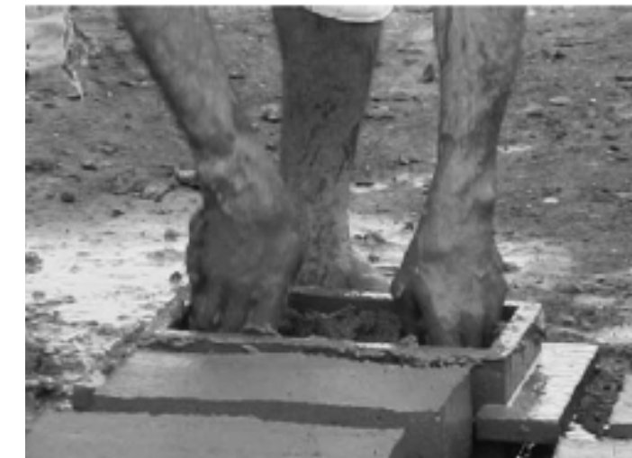
Figura 40. Modelagem de adobes no Ass. Pirituba II, Itapeva, SP. Fonte: Morita, 2010
