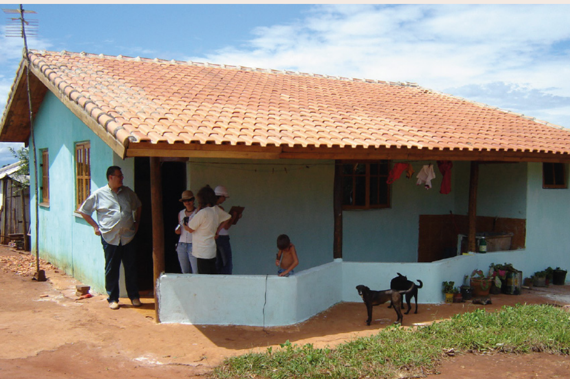
Figura 04. Projeto Inovarural. Casa do Camilo, única casa construída de adobe no projeto. Área de 75m 2 .
