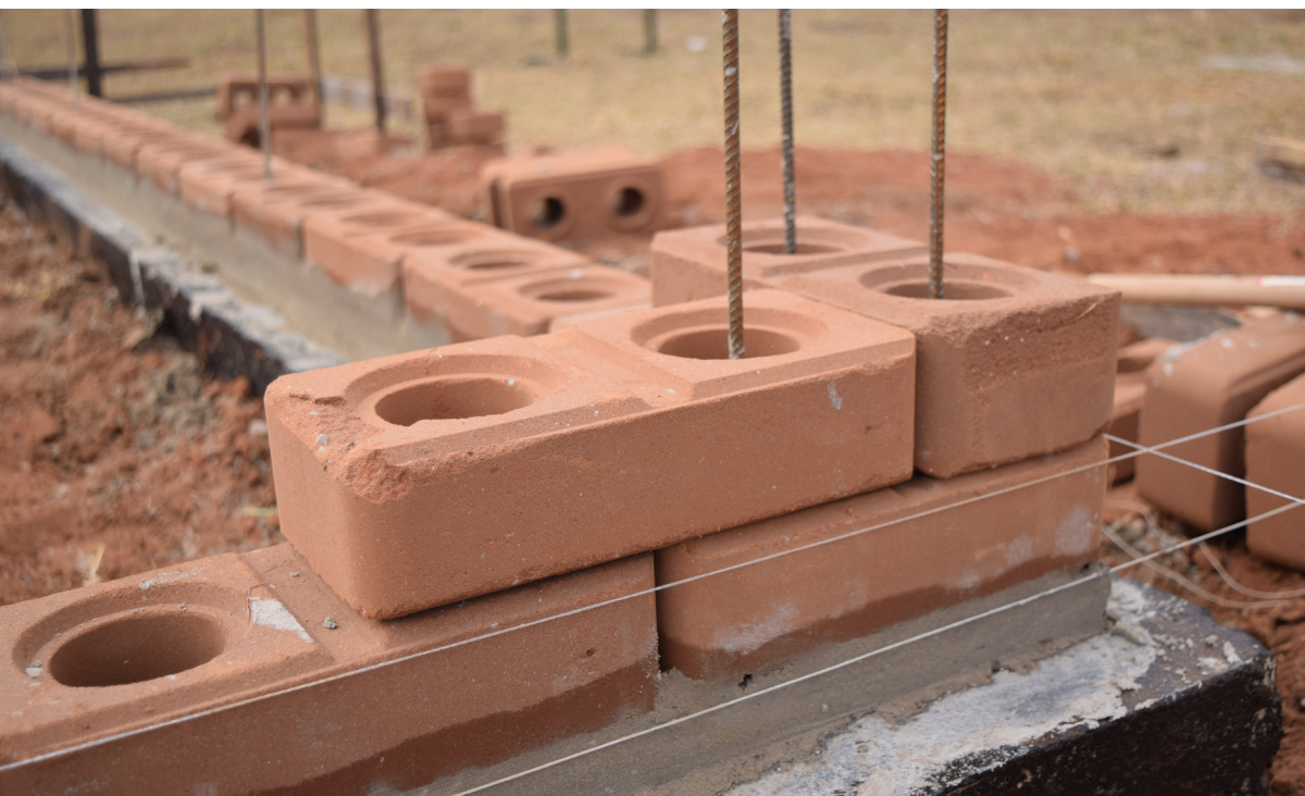
Figura 38. Construção com BTC no Ass. Rosa Luxemburgo. Fonte: Acervo Peabiru TCA, 2021.
