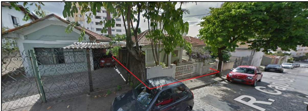
Figura 12 Foto da fachada de edificação existente a ser demolida
