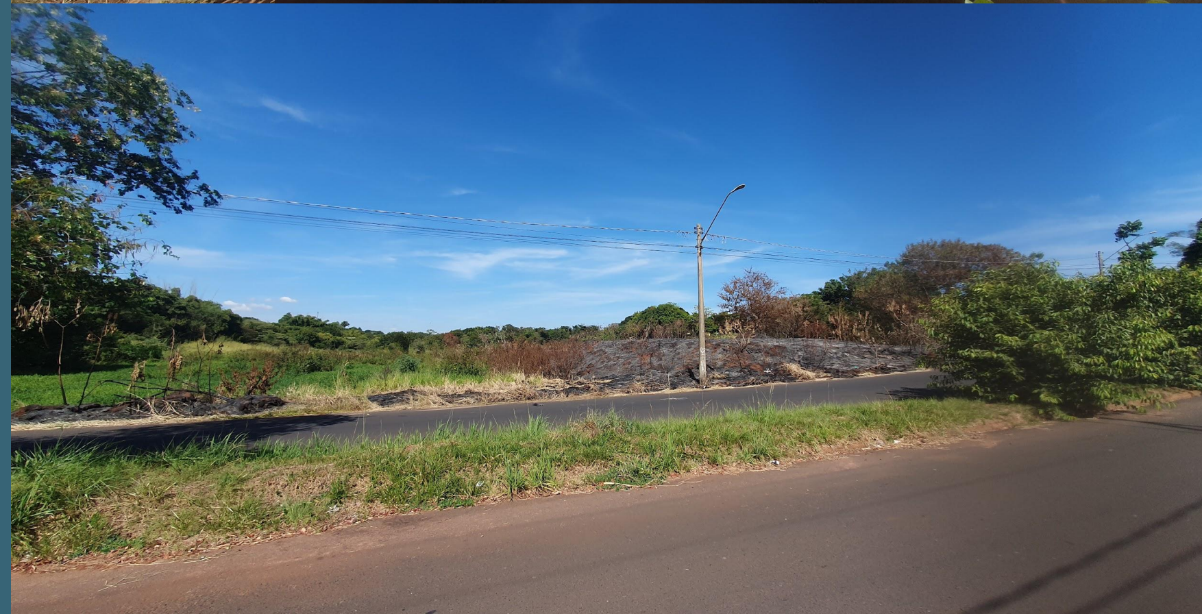
Figura 37 e 38 - Fotos da área de intervenção e entorno Fonte: autor.
