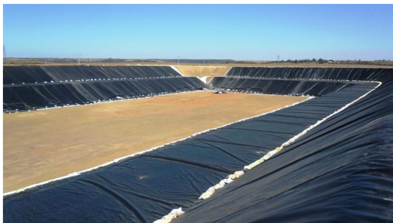
Figura 3.4 - Exemplo de impermeabilização de um aterro com geomembrana de PEAD. Fonte: Atarfil® Geomembranes.
