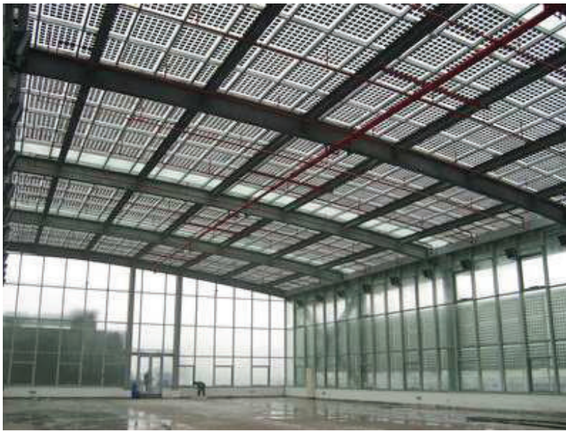
Figura 29: Edifício com módulos PV integrados. Fonte: Shanghai Solar Energy S&T Co, Ltd.
