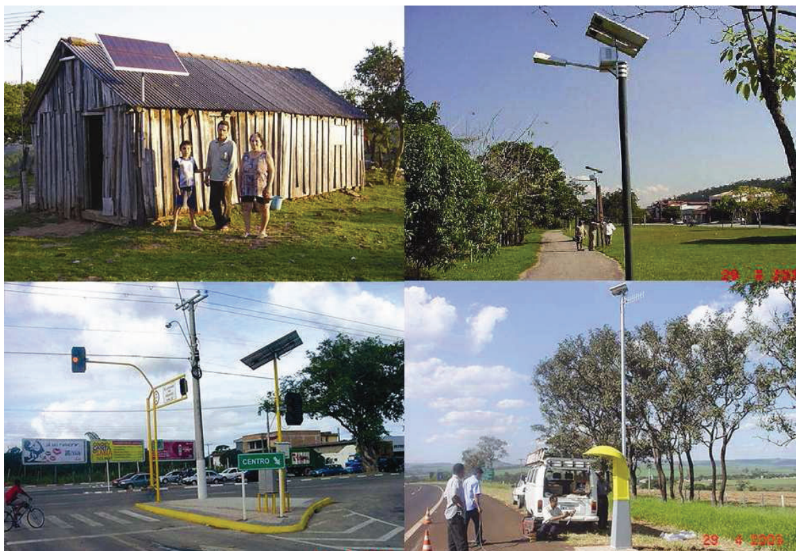
Figura 20: Imagens de sistemas autônomos. Acima à esquerda: edificação rural (fonte: Kyocera); acima à direita: iluminação pública; abaixo à esquerda: sinalização de trânsito (fonte: Kyocera); abaixo à direita: telecomunicações (fonte Kyocera).
