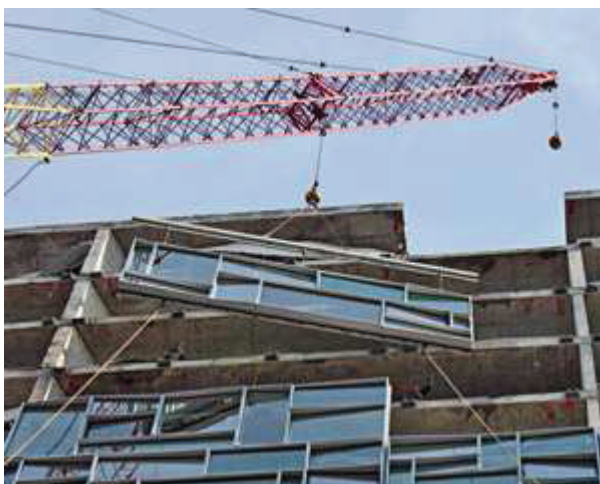
Figura 52: Montagem com painéis unitisados de fachada em projeto de Jean Nouvel. Fonte: Redchalksketch.
