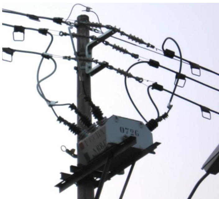
Figura 13: Chave Tripolar a óleo.
