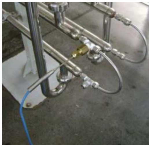
Figura 5 - Termopar inserido na linha do produto
