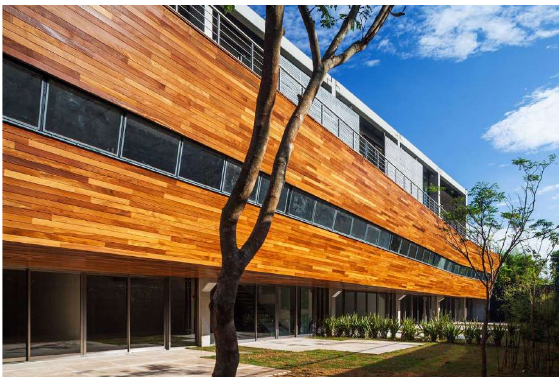
Figura 4: Fachada da parte de trás do Edifício Corujas – Idea!Zarvos.
