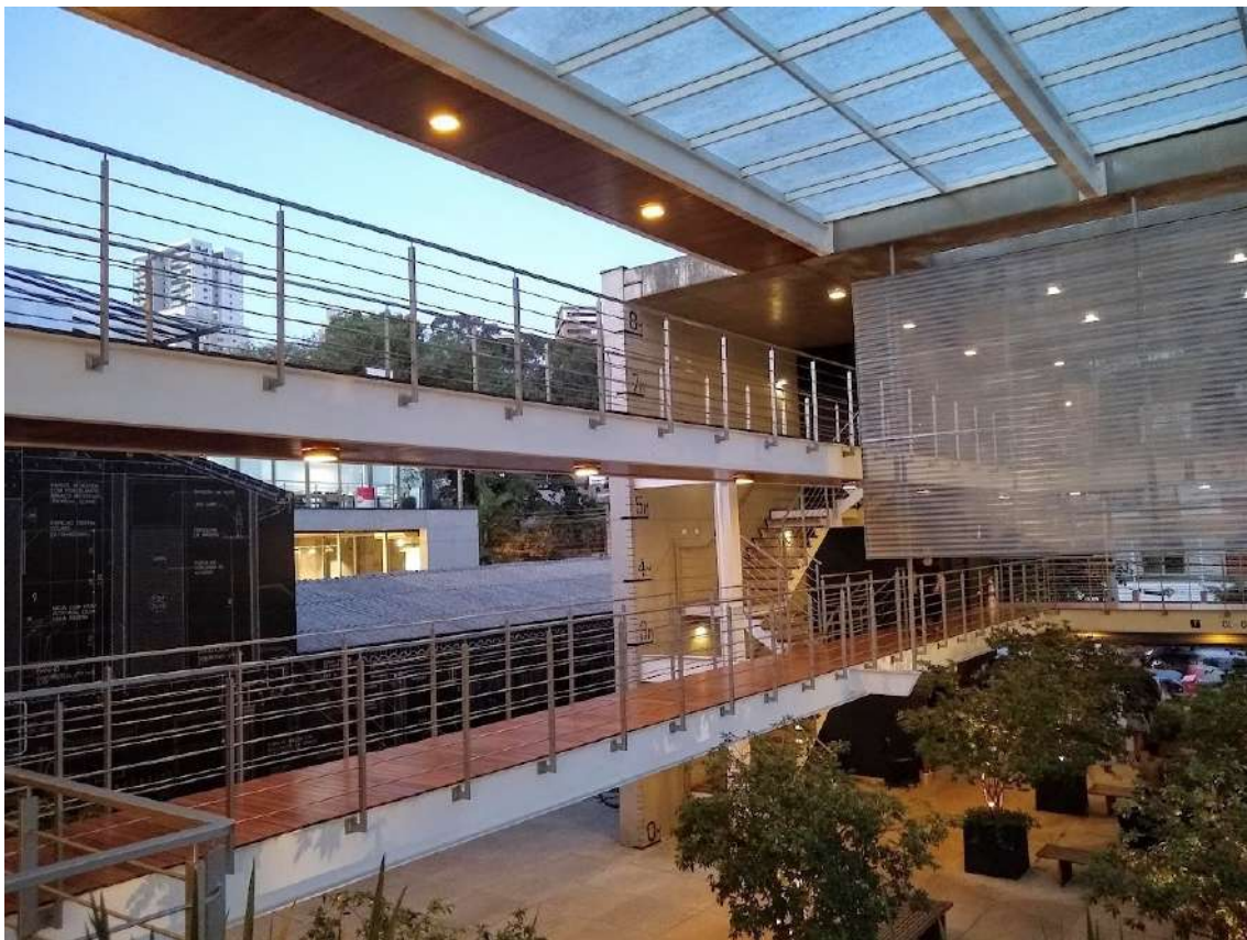
Figura 17: Entrada principal do Edifício Corujas. Vê-se telas de proteção contra a luz.
