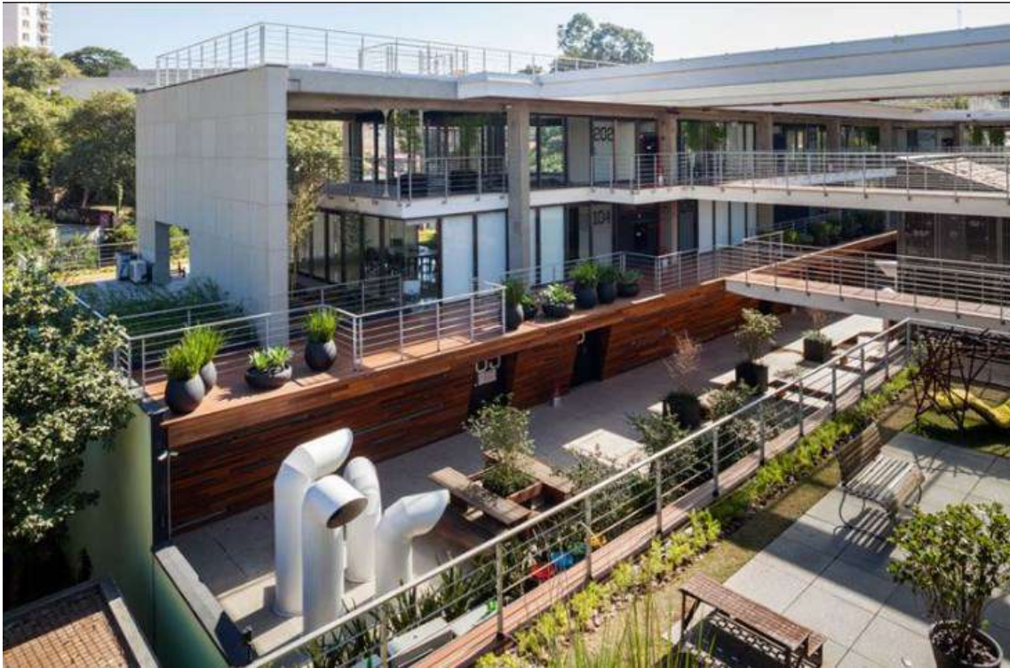
Figura 8: Tubulações de ar como obra de arte no pátio do Edifício Corujas, no distrito de Pinheiros.
