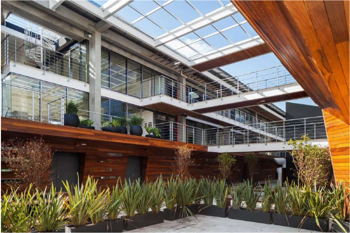
Figura 9: Vista do Edifício Idea Zarvos pelo pátio no térreo.
