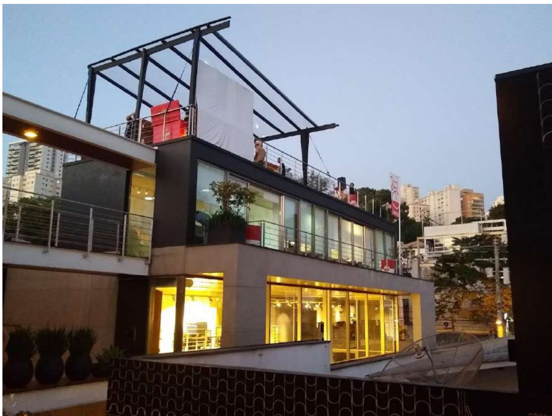
Figura 16: Vista para o primeiro, segundo e terceiro andar do Edifício. Acima, é possível ver a laje de um dos prédios do conjunto, onde há uma churrasqueira e são organizadas festas das agências que alugam os escritórios.
