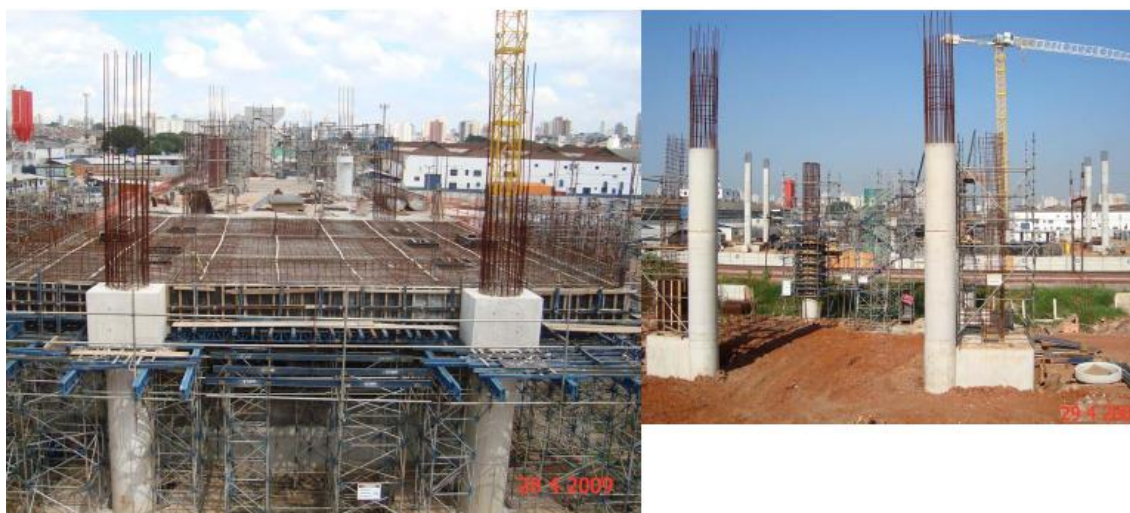
Figura 26: Execução da estação Tamanduateí do Metrô – Fonte: Metrô
