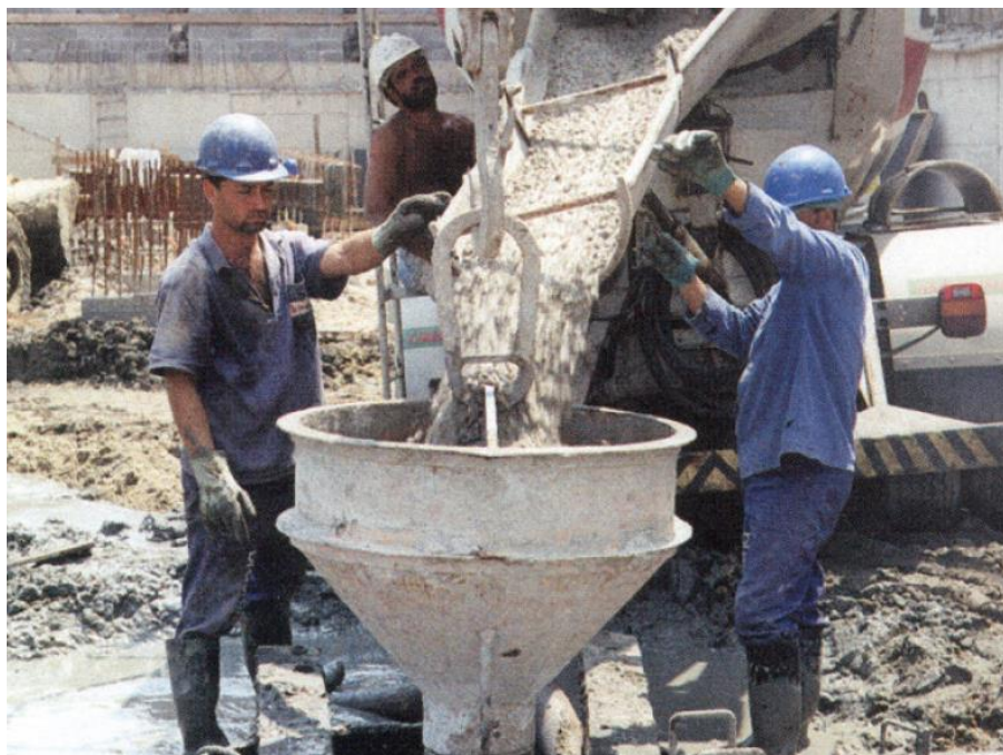
Figura 136: Extremidade Superior do Tubo Tremonha
