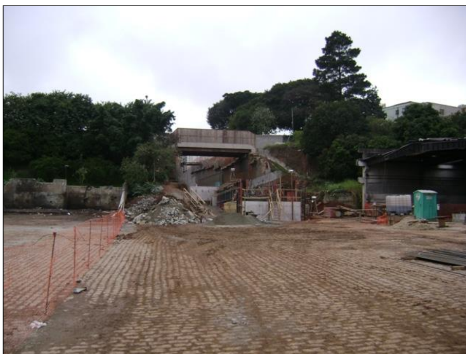
Figura 75: Emboque do túnel
