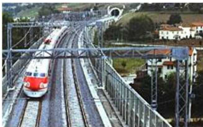
Figura 79: Via com Barreiras Acústicas Laterais
