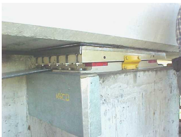
Figura 57: Exemplo de Berço de Deslizamento – Fonte: [WAIMBERG, 2002]
