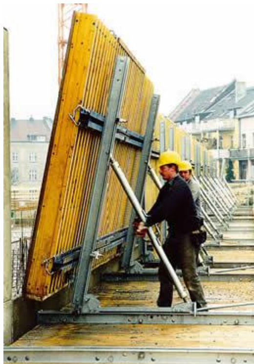
Figura 145: Fôrma Trepante em Detalhe
