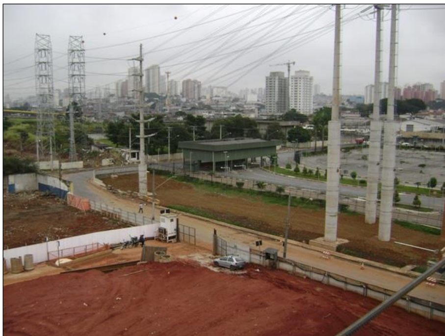
Figura 74: Linha da Eletropaulo
