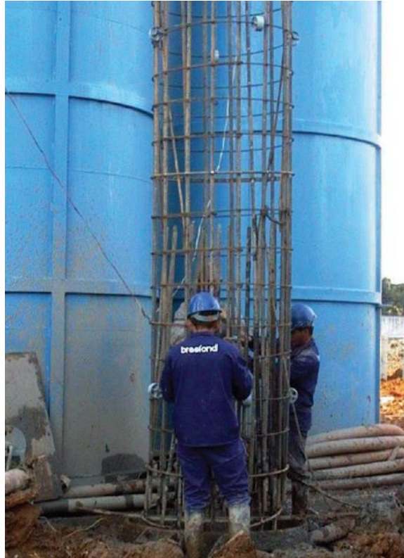
Figura 141: Colocação de Armação
