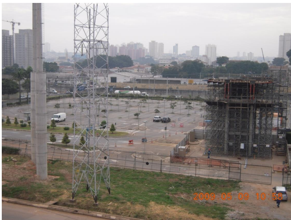
Figura 38: Estacionamento do shopping Central Plaza e sua interferência com a obra
