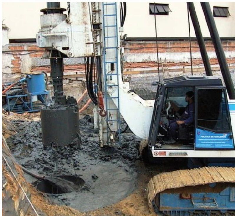
Figura 139: Perfuração e Adição de Lama Bentonítica
