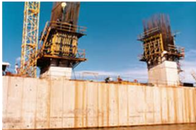
Figura 144: Pilares Executados com Fôrma Trepante
