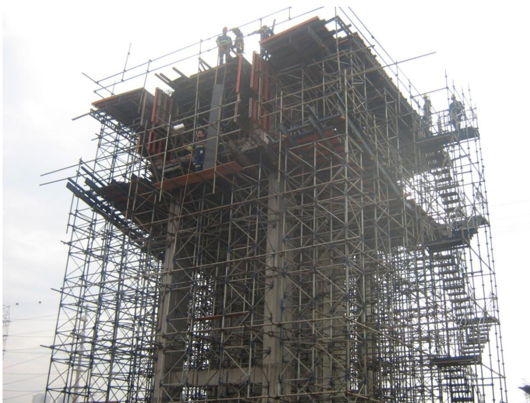
Foto 2: Detalhe de Execução de Aduela de Disparo
