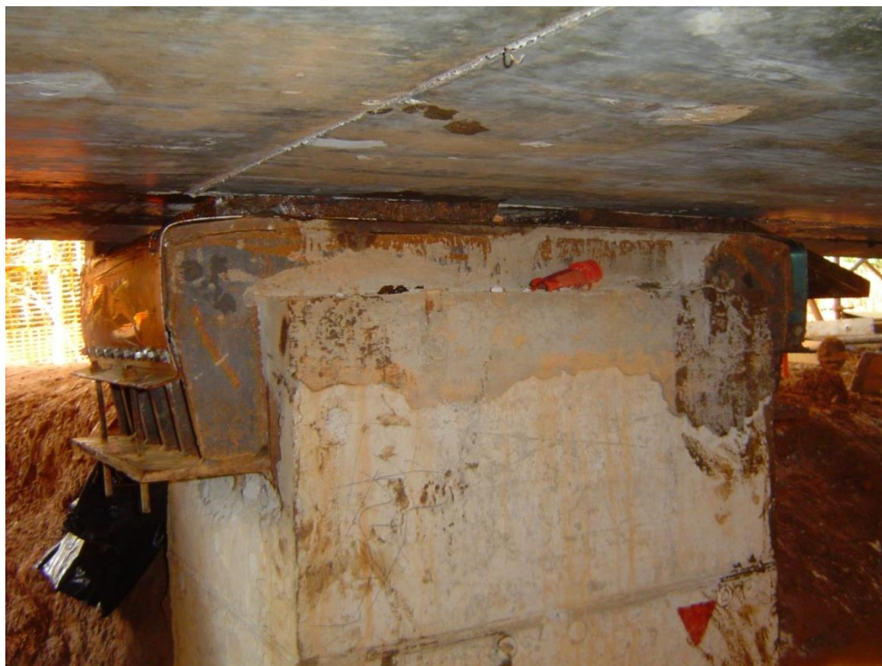
Figura 56: Berço de Deslizamento e Placas de Neo-flon
