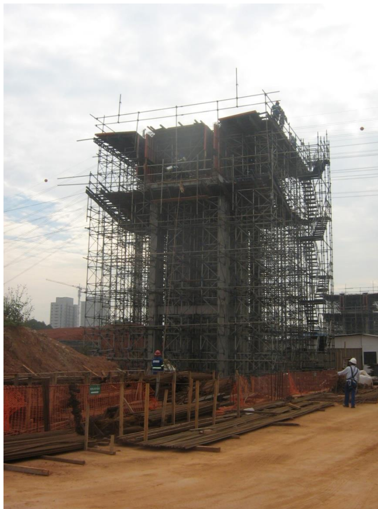
Foto 3: Detalhe de Execução de Aduela de Disparo
