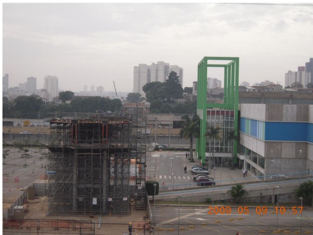
Foto 1: Execução de Aduela de Disparo junto ao shopping Central Plaza
