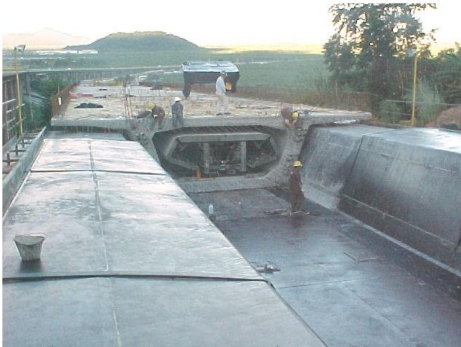
Figura 45: Ponte Executada com Concretagem em duas etapas e sistema de fôrma única – Fonte: [WAIMBERG, 2002]
