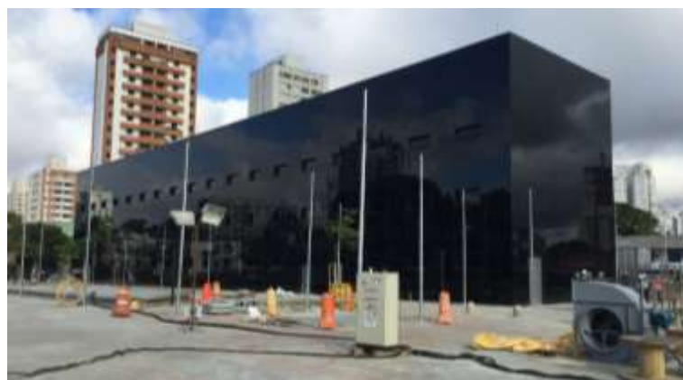
Figura 3.4 - Edifício das Salas Técnicas da estação Brooklin
