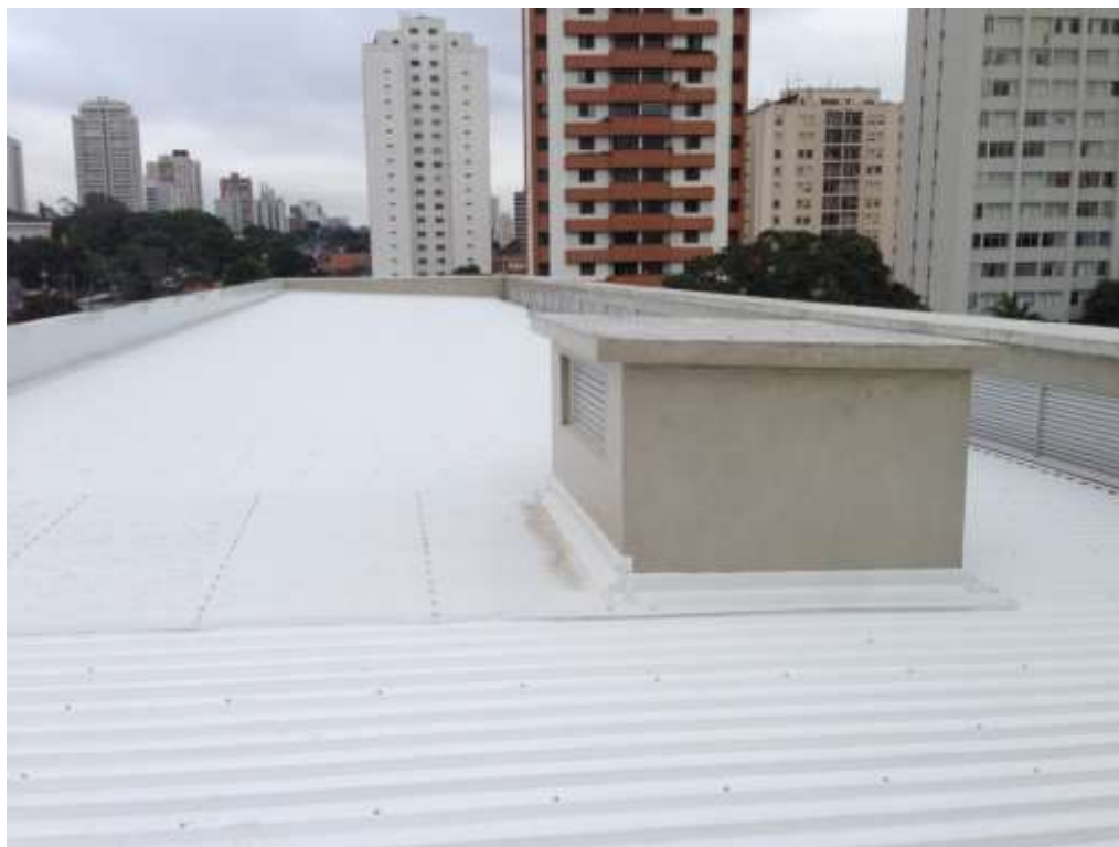
Figura 3.5 - Cobertura do edifício das Salas Técnicas da estação Brooklin
