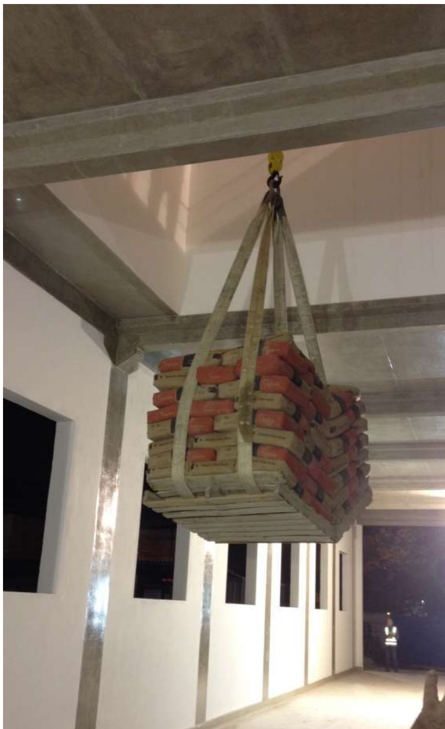
Figura 3.2 - Teste de carga da monovia com 10% acima da carga nominal
