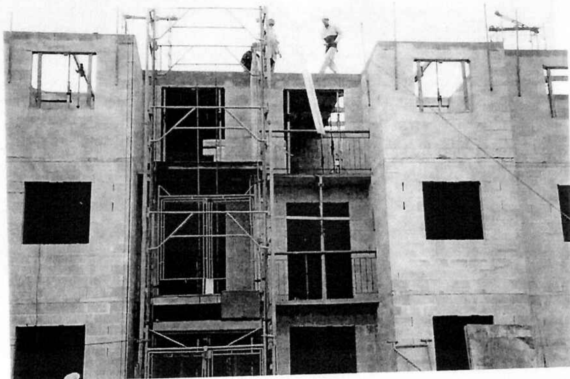
O içamento dos painéis foram feitos através de guincho velox em conjunto com roldana fixada em viga metálica acoplada na torre do guincho.
