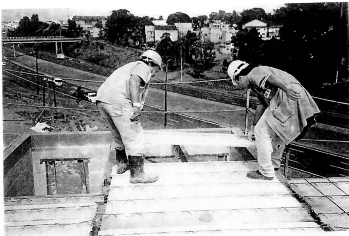
Montagem dos painéis feita manualmente. As extremidades dos painéis são apoiadas diretamente na alvenaria
