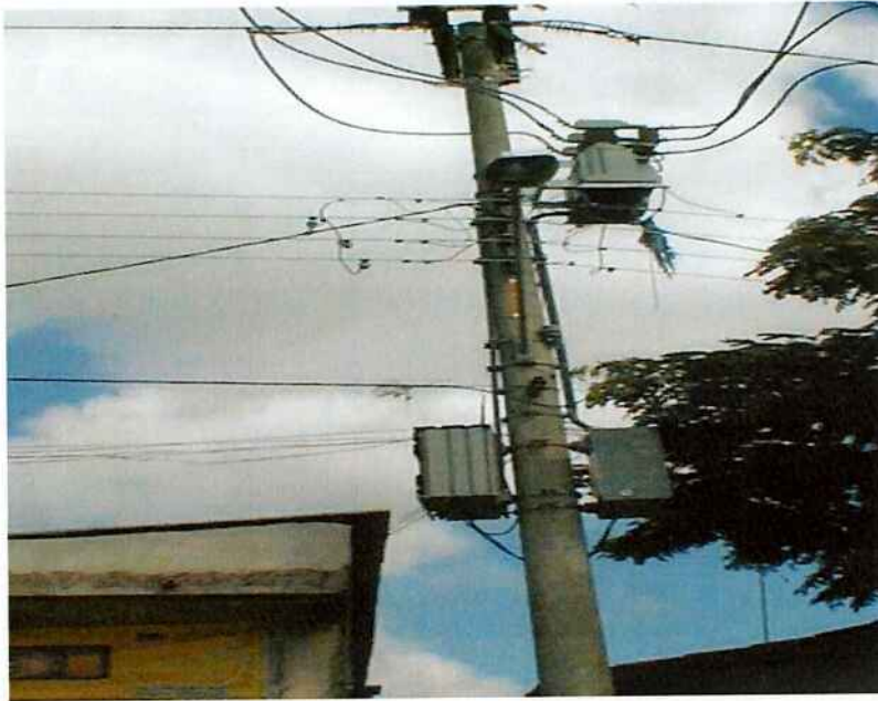
Figura 4 – ETR - Estação de Trabalho Remota
