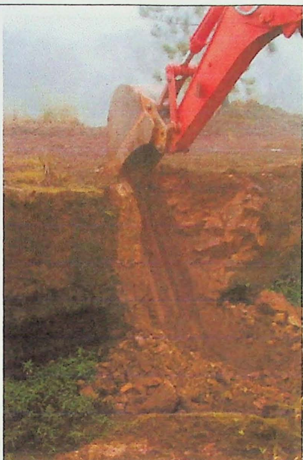
Fotografia 10 - acima - canaletas de amostragem na Trincheira 3.
